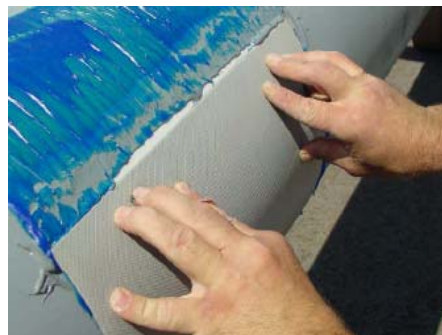
Ilustración 10 Aplicar el Permawrap
