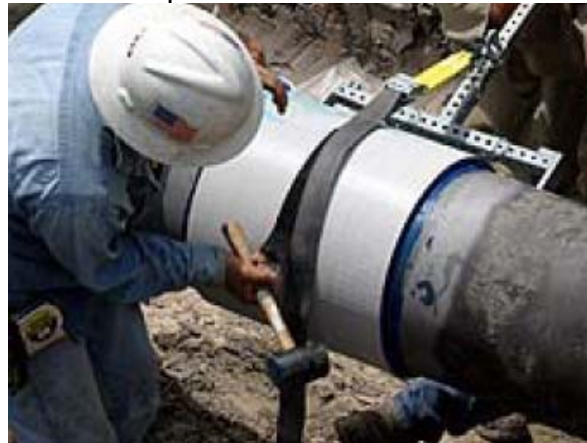
Ilustración 13 Fijar el Permawrap
