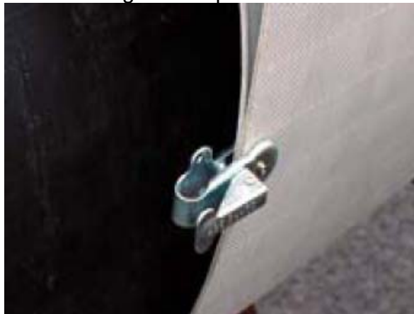
Ilustración 21 Fijación de la manga con clips
