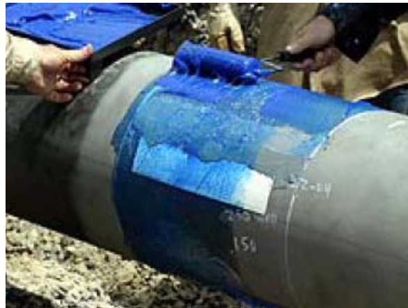
Ilustración 9 Aplicación del Adhesivo
