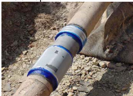
Ilustración 43 Bordes del Weldwrap
