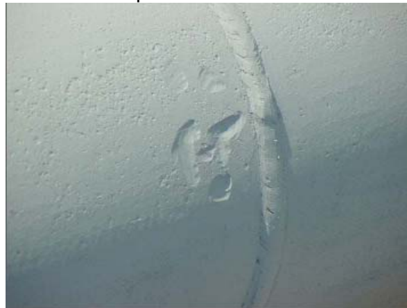
Ilustración 4 Preparación de la Superficie
