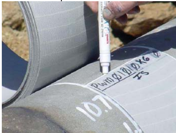
Ilustración 5 Indicar la Zona de Reparación
