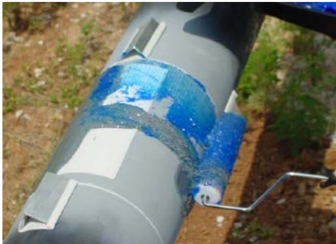
Ilustración 37 Aplicación del adhesivo
