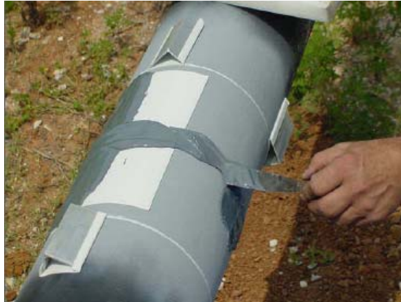
Ilustración 36 Aplicación de la masilla
