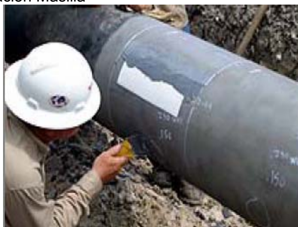
Ilustración 23 Aplicación Masilla
