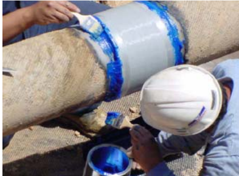
Ilustración 14 Bordes del Permawrap
