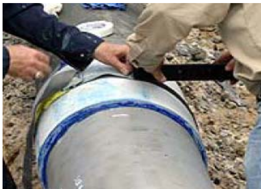
Ilustración 42 Fijando el Weldwrap
