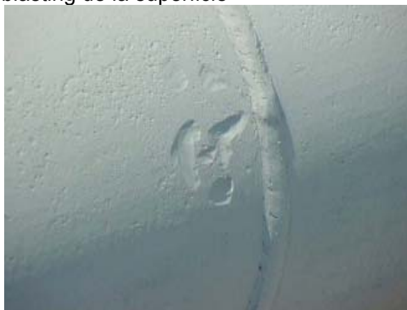
Ilustración 29 Sand blasting de la superficie
