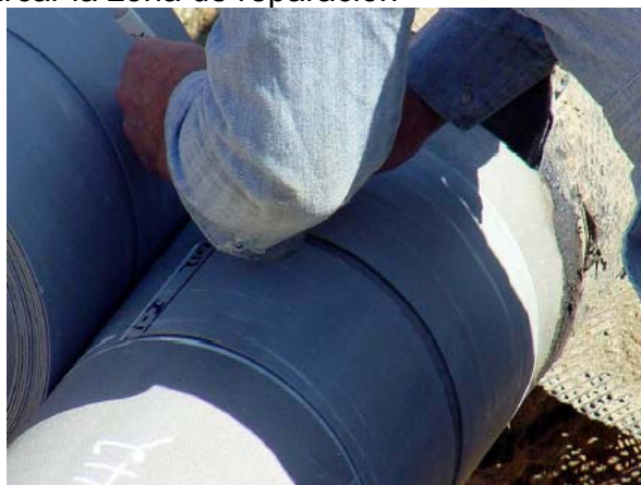
Ilustración 32 Demarcar la zona de reparación
