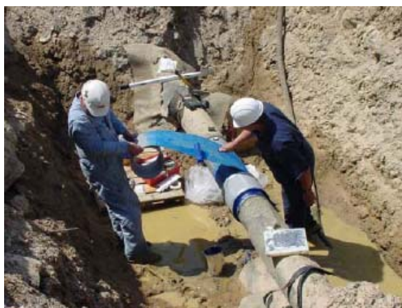
Ilustración 11 Fijación del Adhesivo
