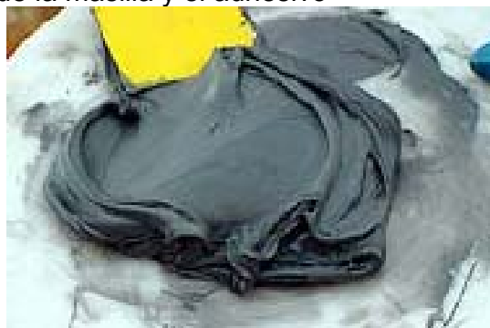
Ilustración 35 Mezcla de la masilla y el adhesivo
