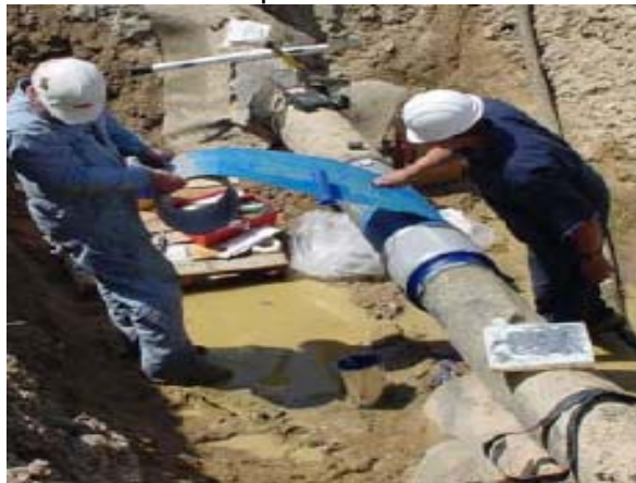
Ilustración 41 aplicación del Weldwrap
