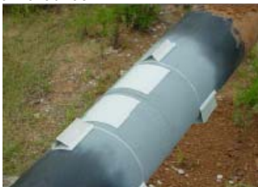
Ilustración 34 Fijar las almohadillas
