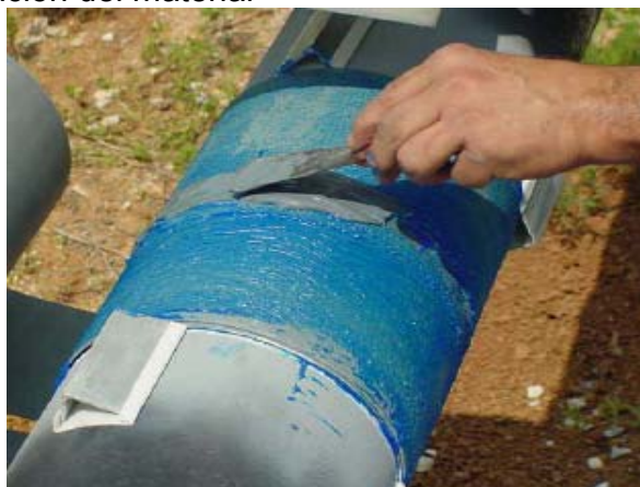
Ilustración 40 Aplicación del material
