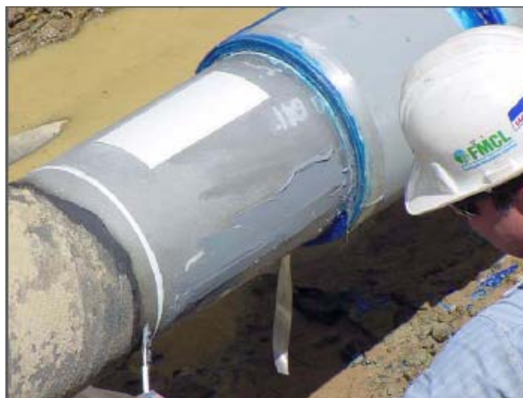
Ilustración 8 Aplicación de la Masilla
