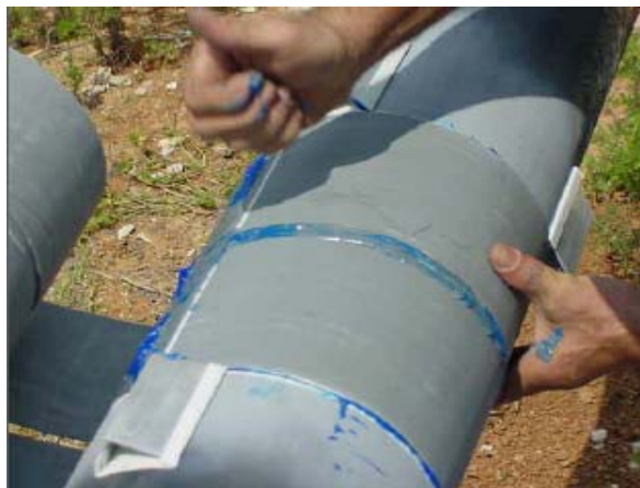
Ilustración 39 Fijación del Weldwrap
