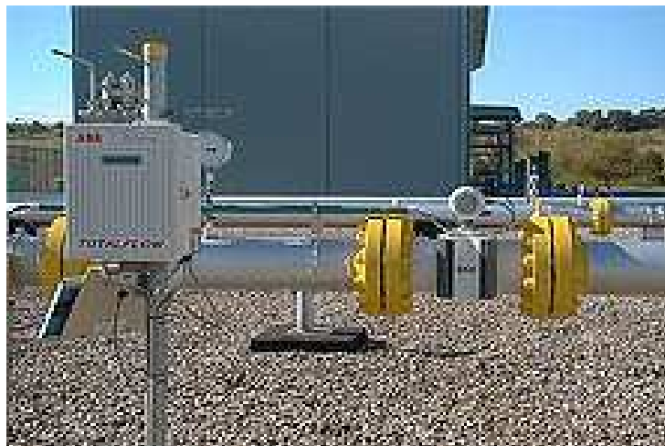
Figura 15. Medidor ultrasónico con Unidad Procesadora
