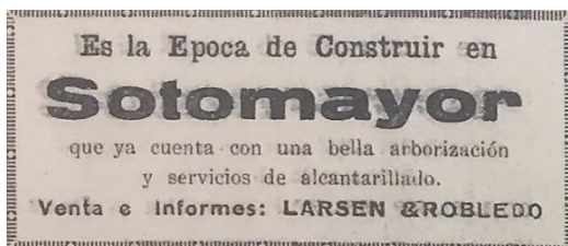
Construcción Barrio Sotomayor, 1942 281
