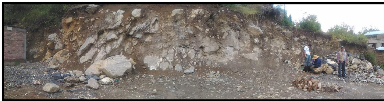
Ilustración 81: Fotografía del Afloramiento 2 en el sector Sur del Municipio de Málaga.
