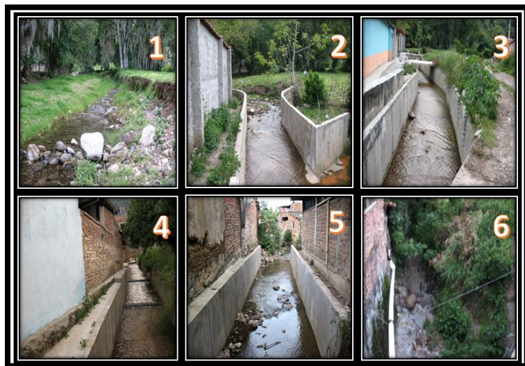
Ilustración 31: fotografías de quebrada la Magnolia.(1) Quebrada Magnolia a su entrada al casco urbano municipal, el día 4 de mayo de 2015. (2) Canal de la quebrada Magnolia. Tramo inicial.(3) Canal de la quebrada Magnolia en su tramo inicial. Medidas: ancho 3.0 metros, profundidad del canal 1.60 m(4) Canal de la quebrada Magnolia a su paso por la carrera 9. Vista aguas arriba.(5). Canal de la quebrada Magnolia a su paso por la carrera 9. Vista aguas abajo. (6) Quebrada Magnolia a su salida del municipio de Málaga, en la confluencia con la Quebrada Seca. (Tomado y modificado del E.O.T(2015)).
