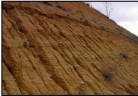
Figura 5. Erosión en surcos paralelos.
