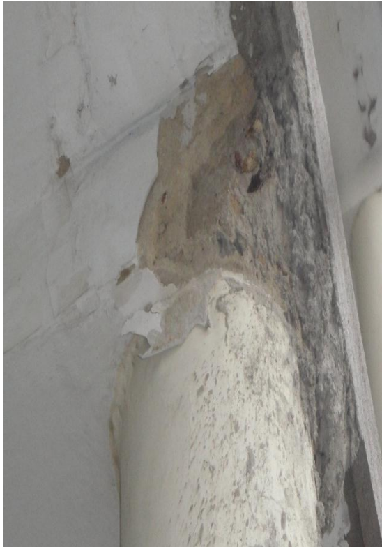
Figura 25. Nodo deteriorado.
