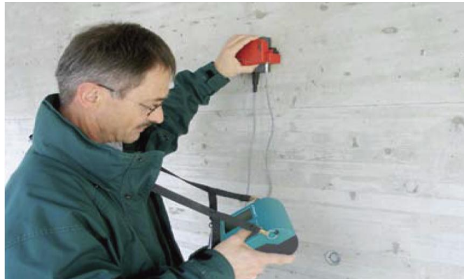
Figura 32. Detección de barras de refuerzo.
