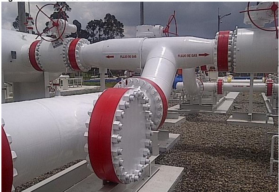
Figura 3.2. Sistema de filtración.
