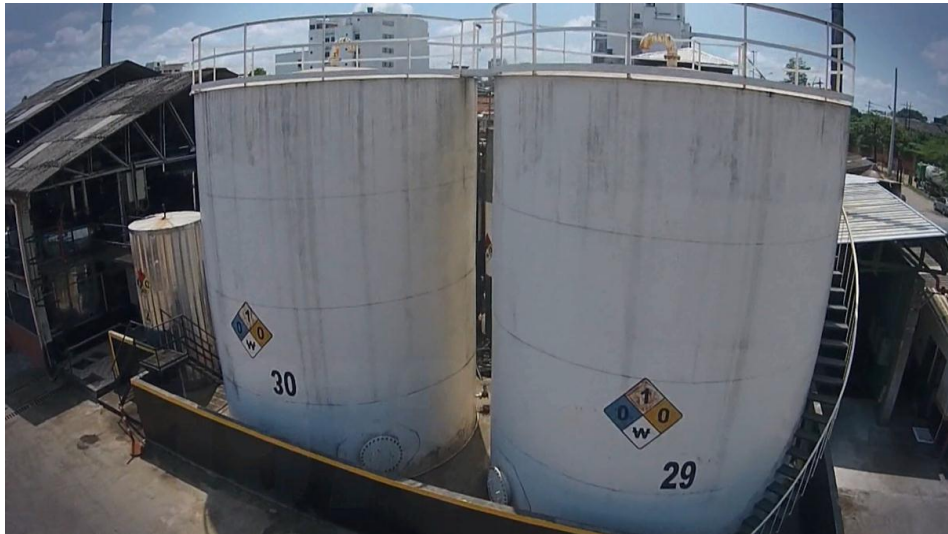
Figura 4. Tanques de almacenamiento de bases lubricantes Proquimsa S.A.S.
