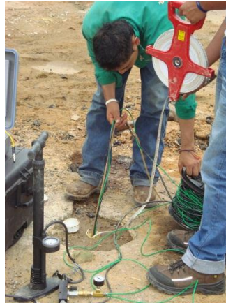
Foto 7 Geófono descendiendo junto con los respectivos cables y la cinta métrica
