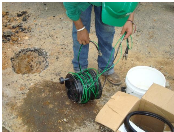
Foto 4 Cables que van conectados al geófono
