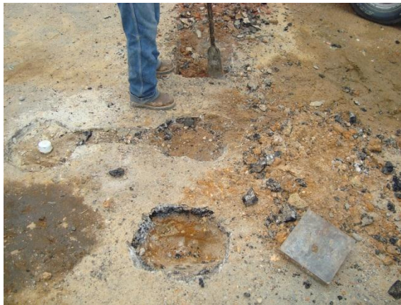
Foto 1. Excavación previa a la colocación de la platina de acero
