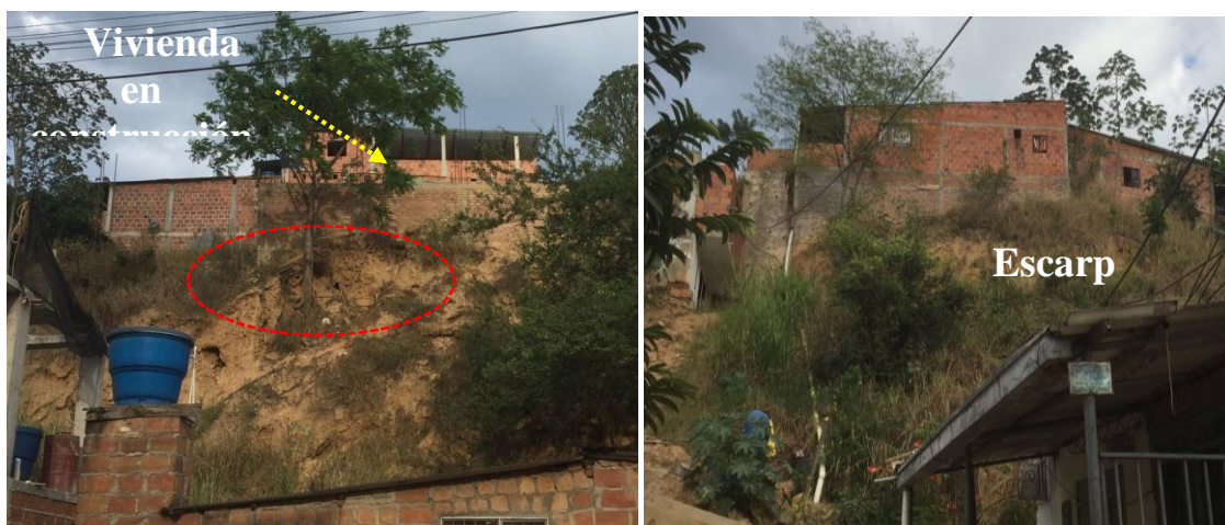
Figura 3. Viviendas en zonas de alta amenaza, hacia el Este del asentamiento.
