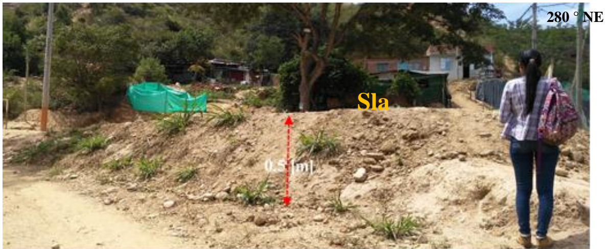
Figura 15. Suelos de llenos antrópicos, estación EA-3, cancha deportiva.
