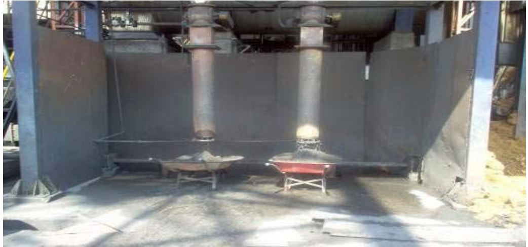
Figura 4. Recolección de hollín de las calderas
