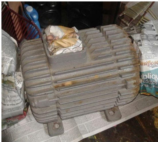
Figura 28. Mantenimiento al motor trifásico
