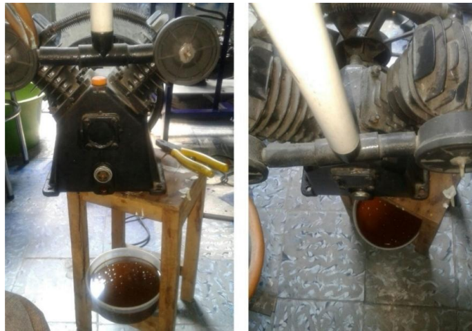
Figura 34. Drenaje de los compresores y reemplazo de aceite
