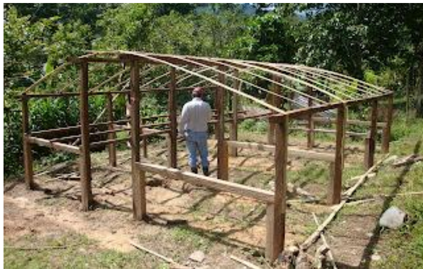
Figura 9. Estructura de marquesina para el secado
