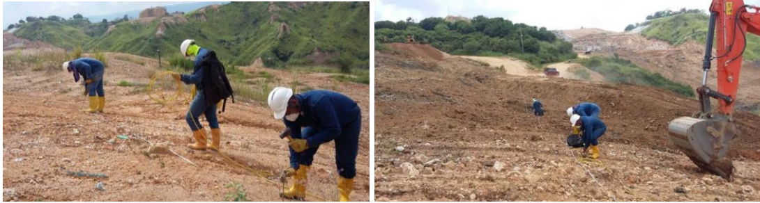
Figura 12. Extendido e instalación de electrodos y multicable para la Tomografía Eléctrica 2D
