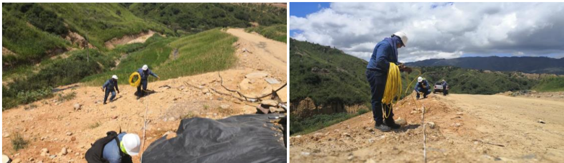
Figura 14. Extendido e instalación de electrodos y multicable para la Tomografía Eléctrica 2D
