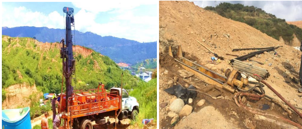
Figura 45. Construcción de pozos de extracción y drenes de penetración horizontal. Adaptado de: EMAB S.A. E.S.P
