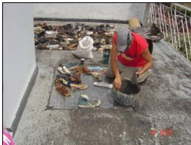
Figura 31: Aplicación del Pegamento
