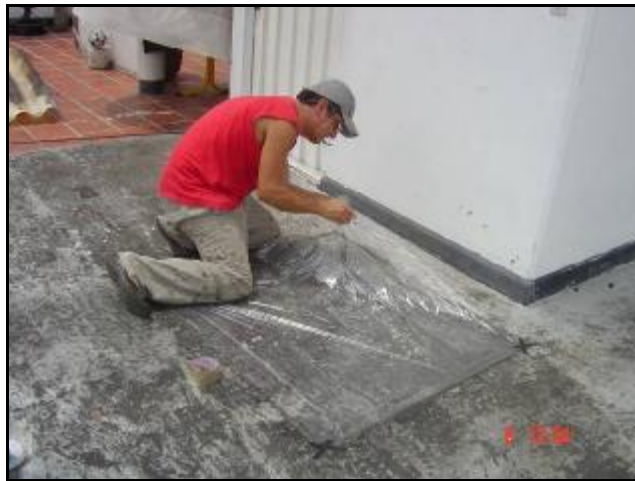
Figura 30: Preparación inicial de la cubierta.
