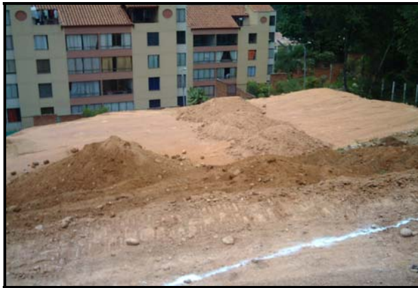
Figura No. 10 Terreno de relleno donde se cimentó el costado sur de la Torre 10 N-2.20.
