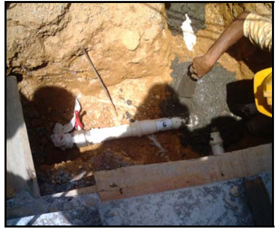
b. Atraque en concreto de 2500 p.s.i
