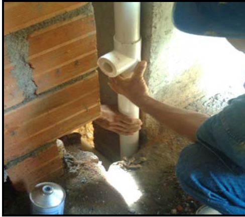
a. Instalación de la montante de 1”
