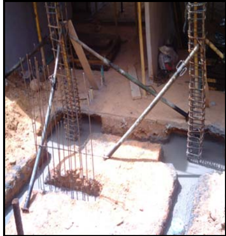
a. Cimentación del Punto Fijo
