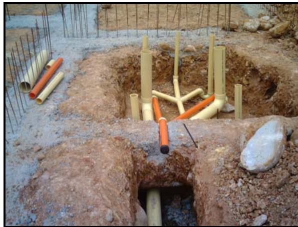
Figura N.º 8. Tubería de desagüe de baños 1 er Piso
