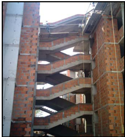
c. Mampostería y frisado
