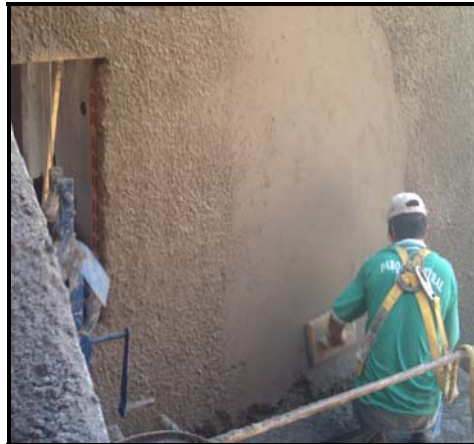
b. Acabado final con la llana
