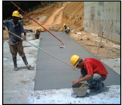
b. Alisado con llana para dar acabado rugoso
