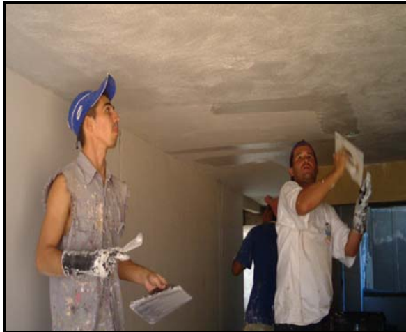
Figura N.º 31. Aplicación del graniplast blanco en la placa de apartamentos.
