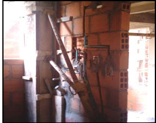
b. Tramos verticales en los muros
