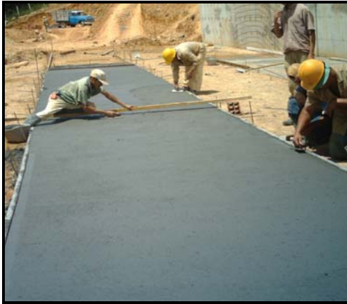
a. Después del vaciado se extendió y niveló con regla y espátula
