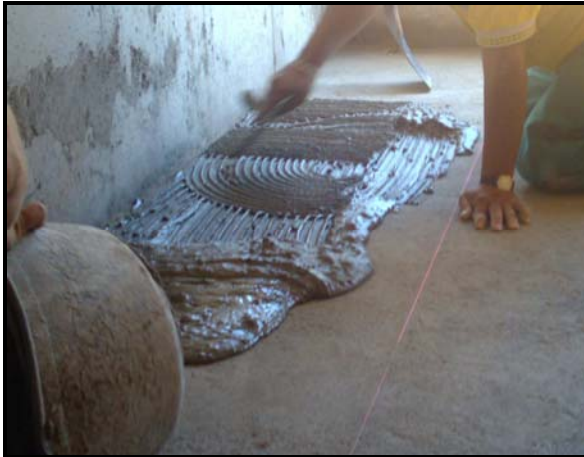
Figura N.º 29. Aplicación del pegacord utilizando hilo de referencia
