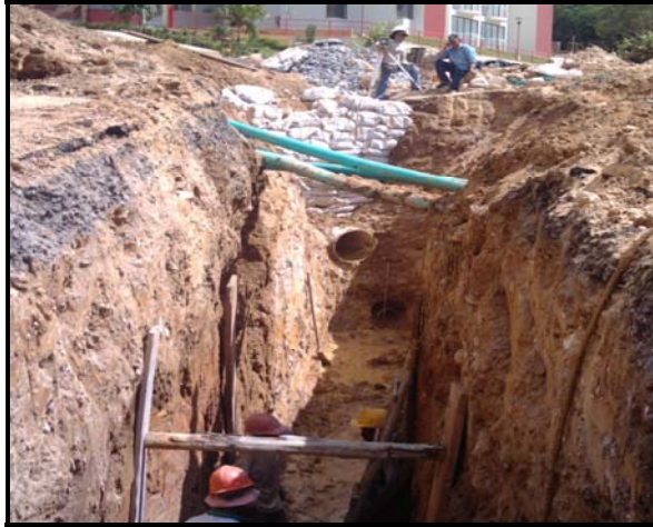
Figura N.º 12 Excavación con maquina; se asegura la zanja con entibaciones y sacos de arena.
