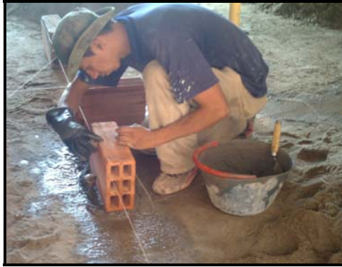
a. Replanteo de muro divisorio
