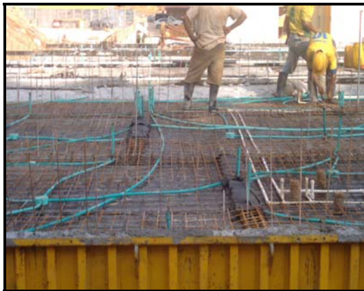
a. Tramos horizontales en la placa
