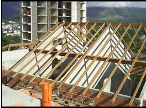
a. Estructura de la cubierta
