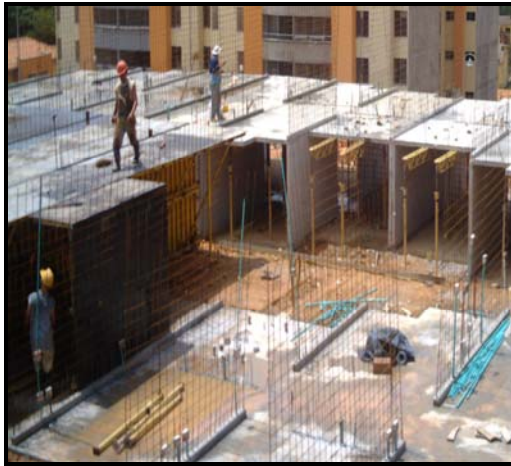
a. Colocación de la formaleta túnel junto a los dados
