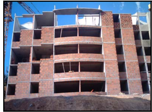
b. Mampostería exterior Torre 9
