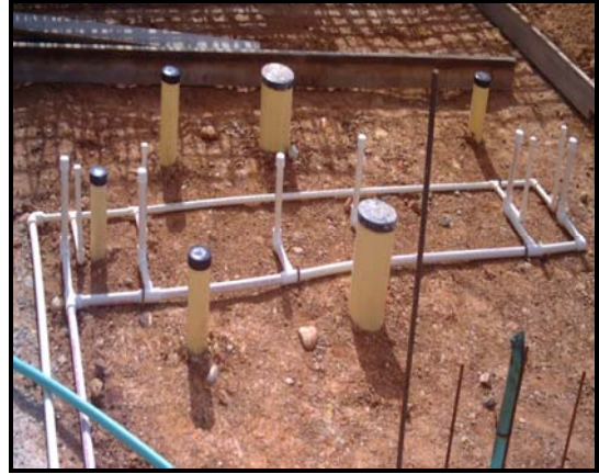
b. Tramo de tubería de agua fría y caliente de los baños
