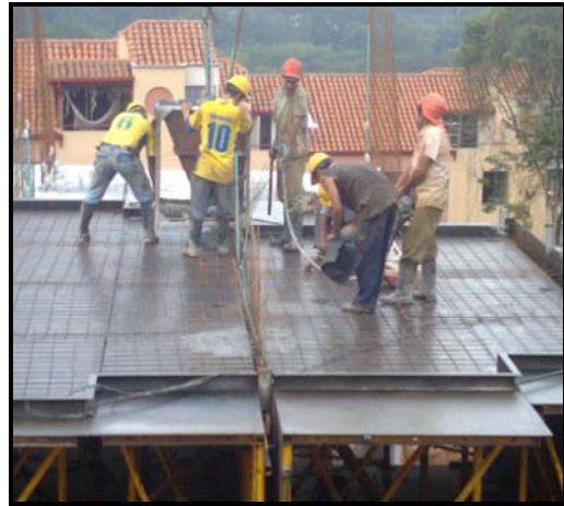
b. Vaciado del concreto para la fundida de las pantallas
