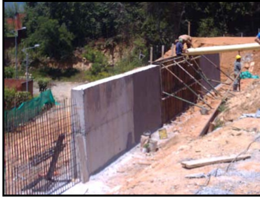
c. Fundida del cuerpo del muro
