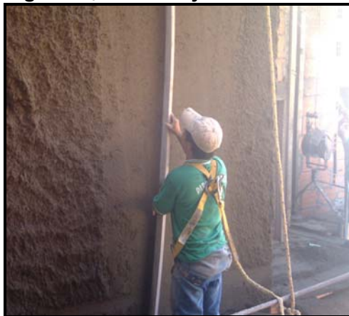
a. Dando el espesor con la regla
