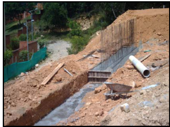
b. Cimentación apoyada en las pilas
