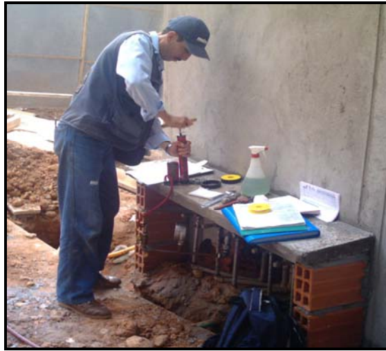
Figura No 23 Pruebas de hermeticidad para dar conexión.
