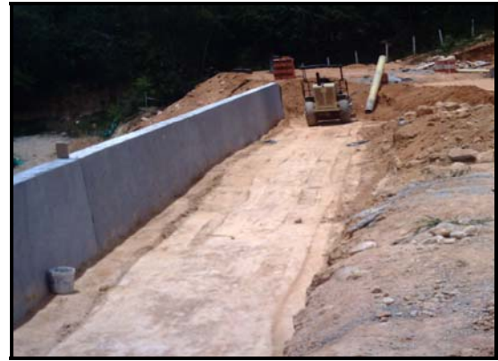
d. Compactación relleno a nivel parqueaderos
