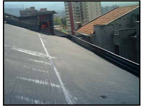
b. Impermeabilización con manto
