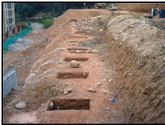
a. Pilas de concreto ciclópeo
