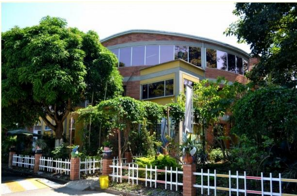
Figura 5. Instalaciones de los laboratorios del CROM-MASS.
