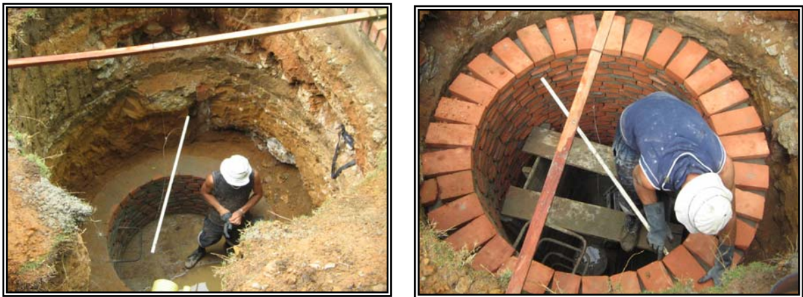
Figura 73. Construcción de pozo para recolección de aguas negras y lluvias, Marzo de 2006.
