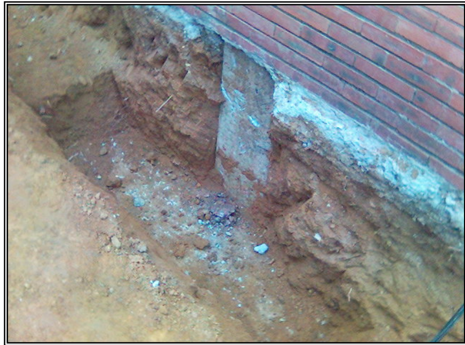
Figura 49. Cimentación de la estructura existente, febrero de 2006.
