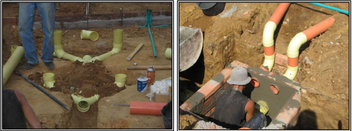
Figura 25. Instalaciones hidrosanitarias, Febrero de 2006.
