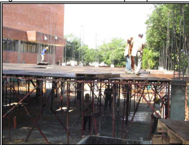
Figura 30. Formaleteado de placa para fundida de entrepiso, Febrero de 2006
