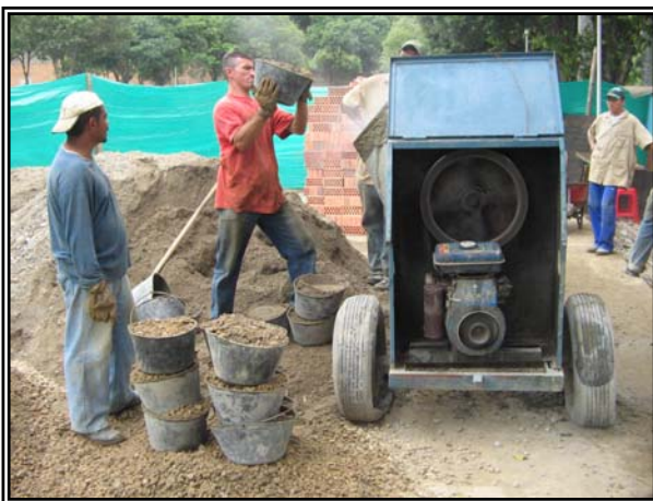
Figura9. Mezclado del concreto con trompo en obra, febrero de 2006.
