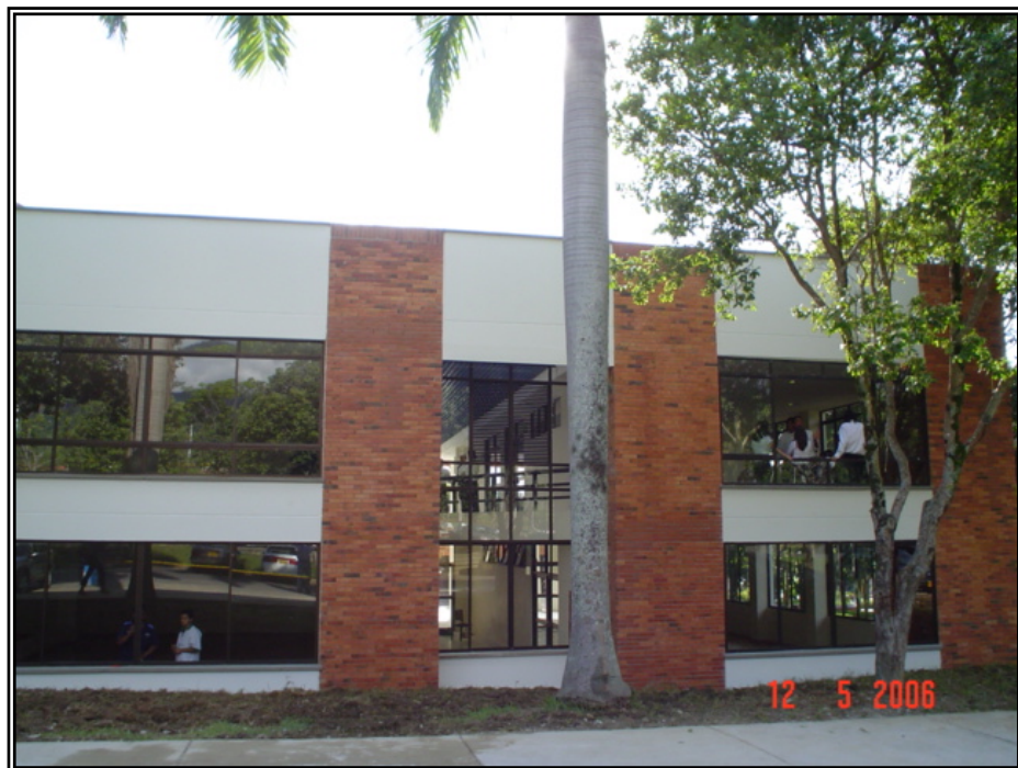
Figura 44. Acabado final de fachada norte, Mayo de 2006.
