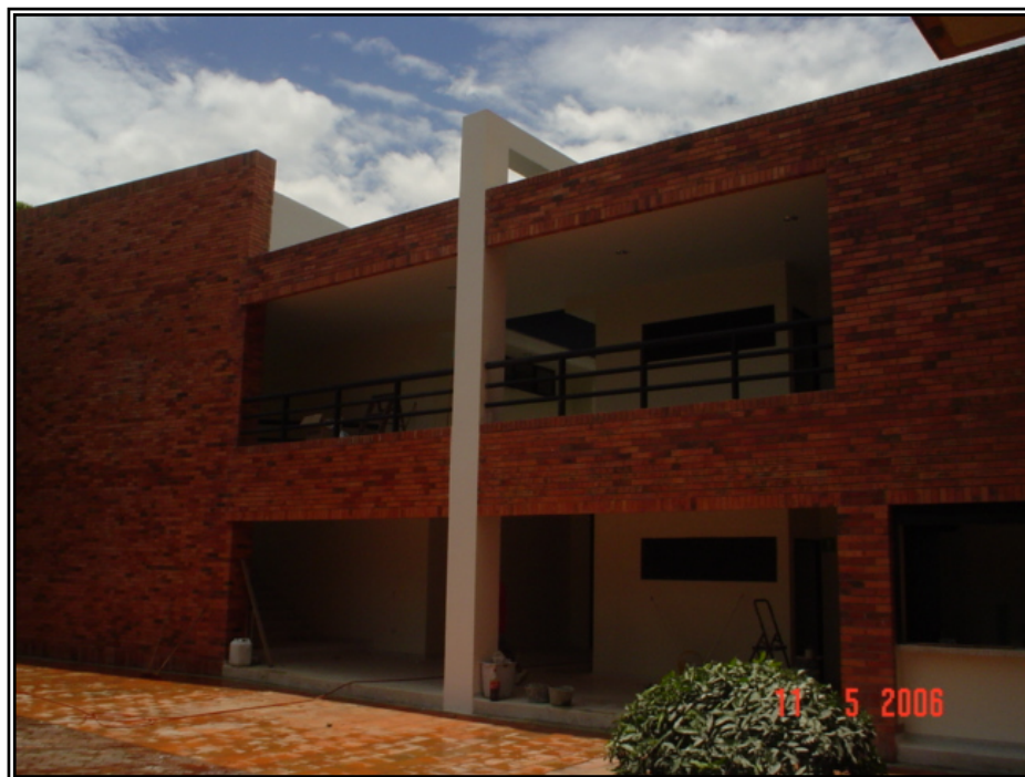
Figura 42. Acabado final de fachada occidental, Mayo de 2006.
