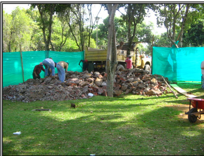
Figura4. Cerramiento y lugar de cargue de volquetas, febrero de 2006.
