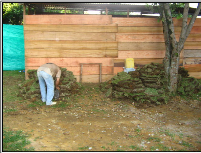
Figura 5. Construcción de bodega para materiales, febrero de 2006.
