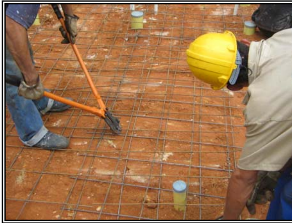
Figura 27. Extendido de malla de antepiso, Febrero de 2006.
