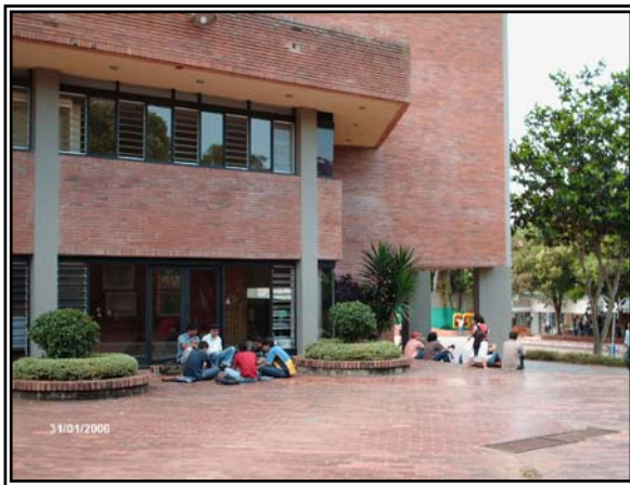
Figura 68. Tramo hacia donde se haría la acometida, enero de 2006.
