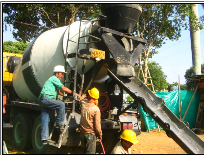
Figura 7. Vehículo concretero o mixer, febrero de 2006.
