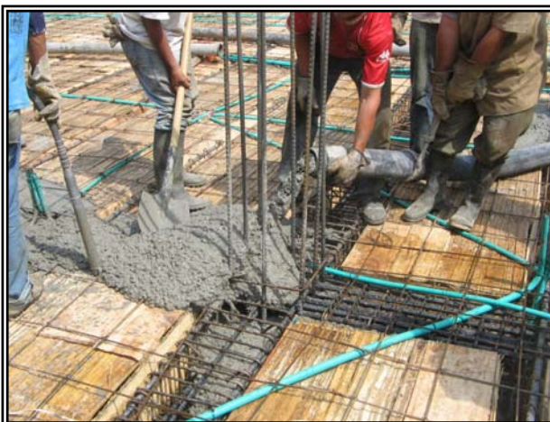
Figura 32. Fundida de placa de entrepiso, Marzo de 2006.
