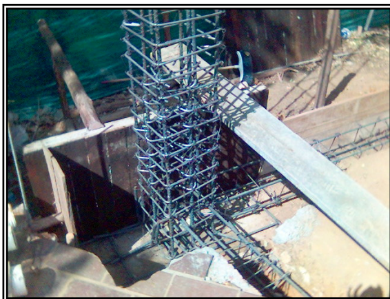
Figura 55. Zapata que quedaba sobre el terreno. Febrero de 2006.
