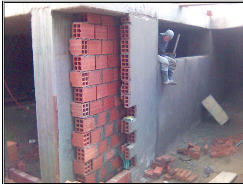
Figura 58. Muro doble, marzo de 2006.
