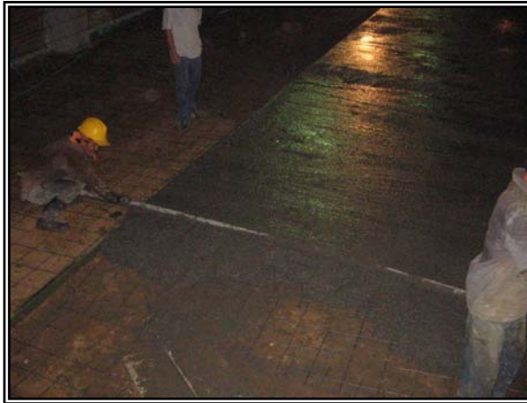
Figura 29. Ensayo para asentamientos en terreno, Febrero de 2006.
