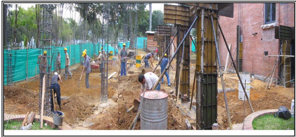
Figura 24. Panorámica de la obra en proceso de formaleteado de columnas, Febrero de 2006.
