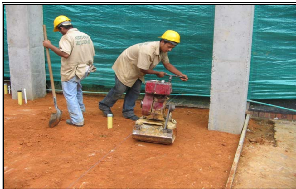
Figura 26. Compactación de terreno para fundida de antepiso, Febrero de 2006.
