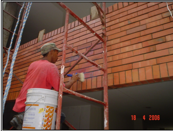
Figura 41. Aplicación del hidrófugo en muros, Abril de 2006.
