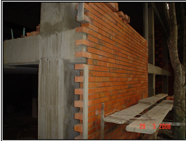
Figura 65. Mampostería en ladrillo Hoffman.
