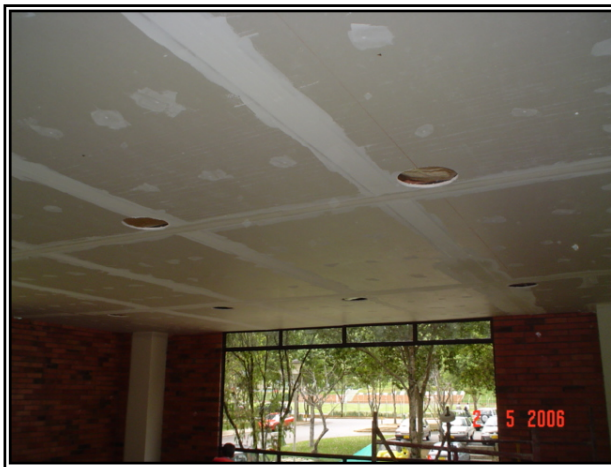
Figura 38. Instalación de cielo raso en Drywall, Abril de 2006.
