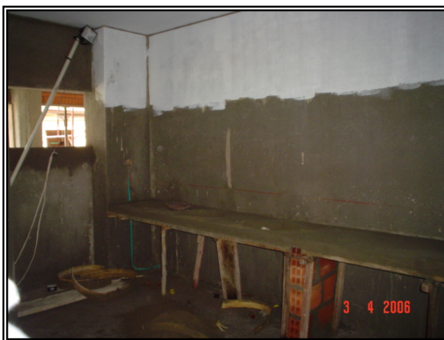
Figura 37. Estuco y pintura de muros, Abril de 2006.
