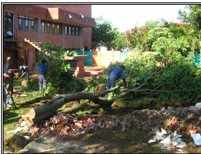
Figura3. Vegetación dada de baja en sitio de la obra, febrero de 2006.
