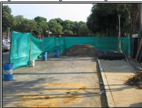
Figura 13. Lugar de descargue de material.
