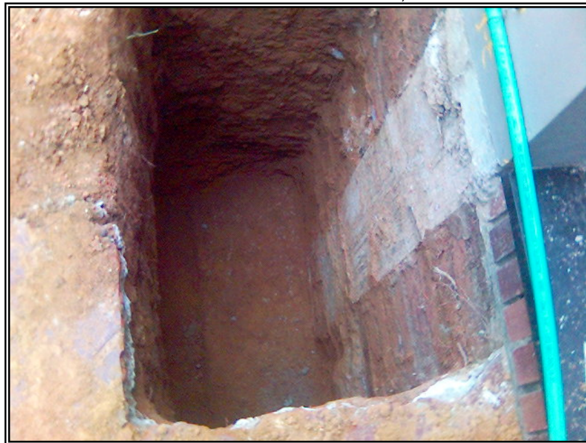
Figura 48. Cimentación de la estructura existente, febrero de 2006.
