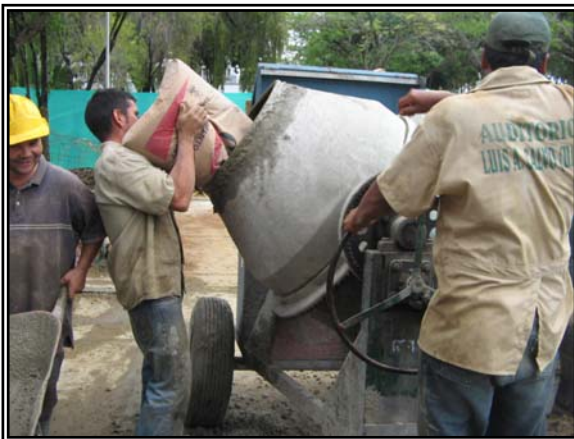
Figura8. Proceso de preparado del concreto en obra, febrero de 2006.
