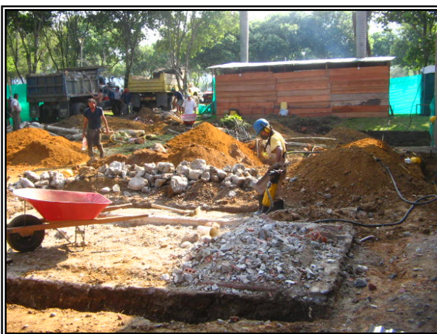
Figura 19. Demoliciones, Febrero de 2006.
