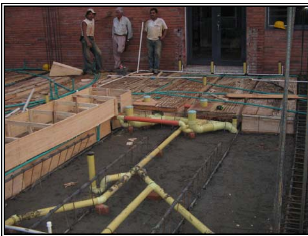
Figura 31. Formaleteado de la placa para fundida de entrepiso, Febrero de 2006.
