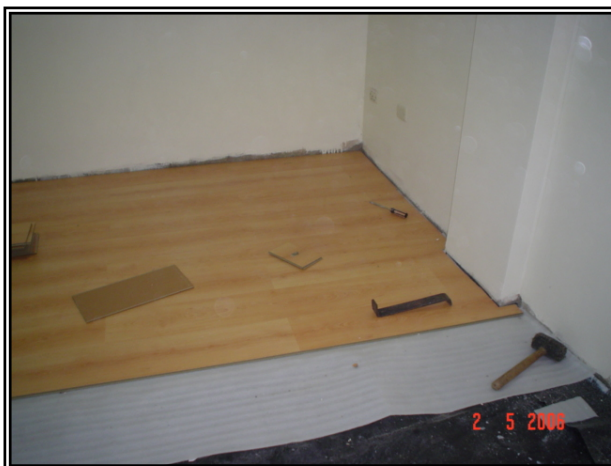
Figura 63. Piso en madera.
