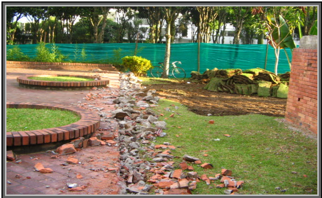
Figura 17. Procesos de inicio en obra, febrero de 2006.
