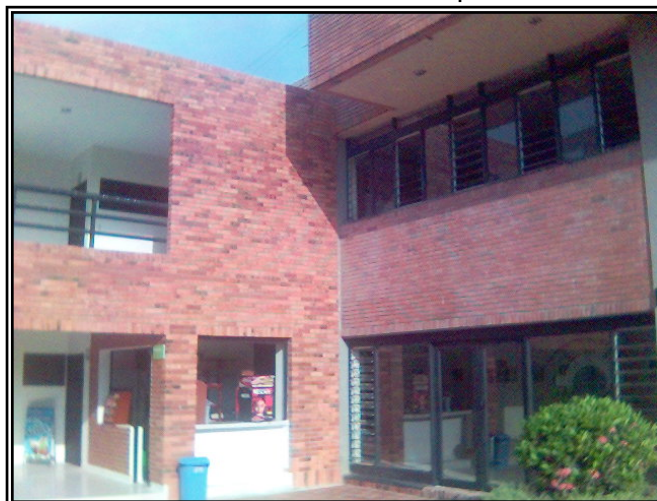
Figura 66. Vista de continuidad en mampostería a la vista.
