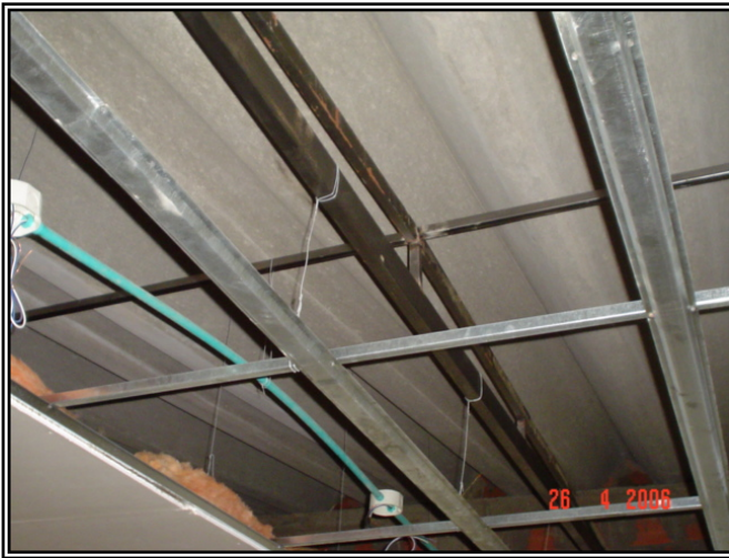
Figura 67. Estructura para cielo raso.
