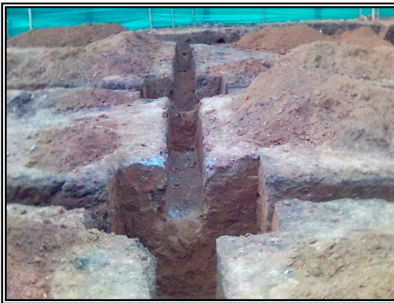
Figura 20. Excavaciones para cimentación, Febrero de 2006.
