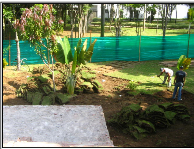
Figura 18. Descapote del área a construir, Febrero de 2006.
