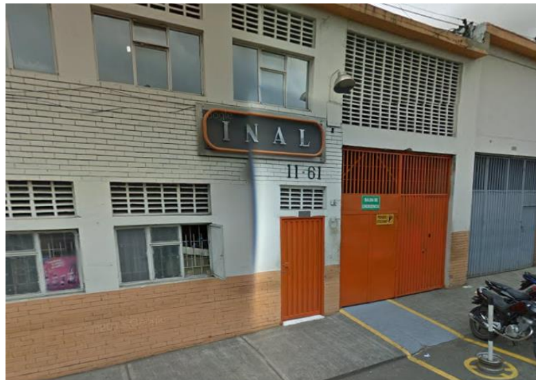
Figura 1, Instalaciones de Industrias Acuña Ltda.
