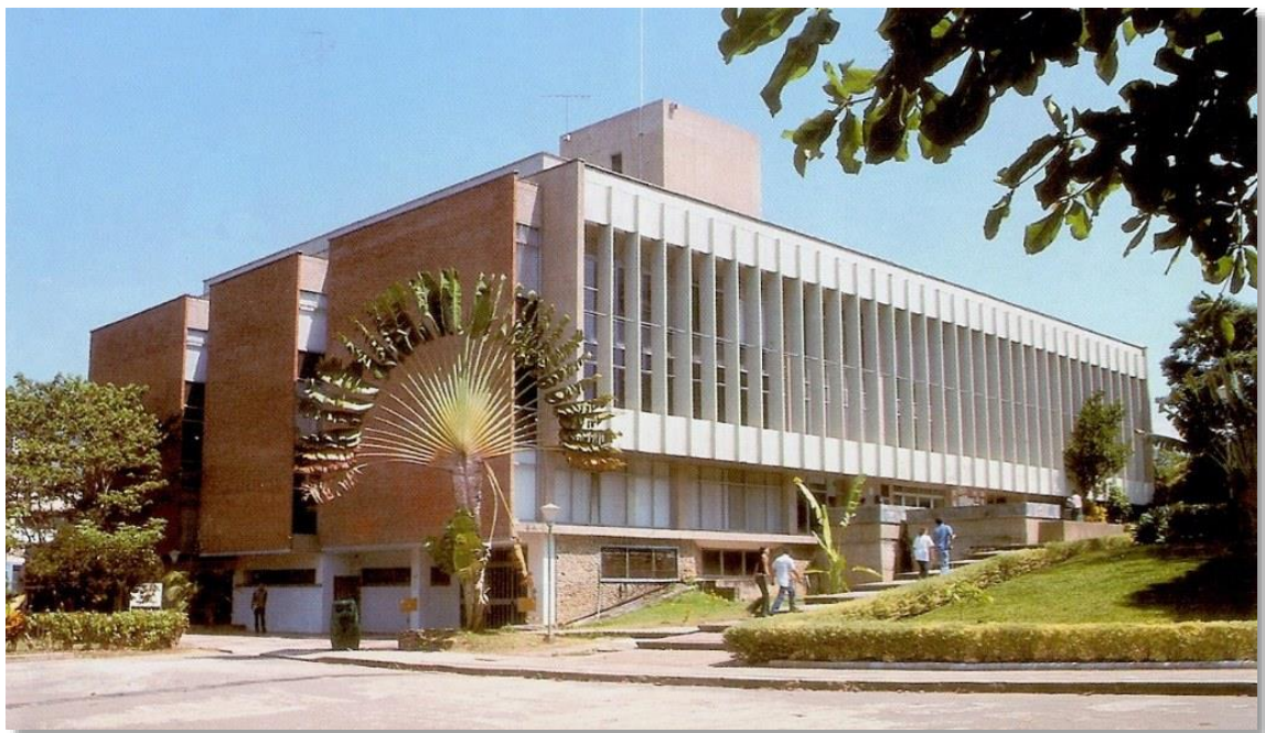
Figura 11. Edificio de Biblioteca.
