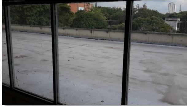
Figura 12. Terraza descubierta en el lado sur del Edificio de Biblioteca.
