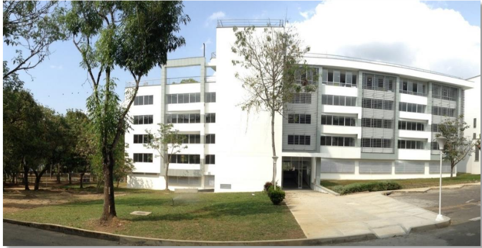
Figura 9. Edificio de Ingeniería Eléctrica.
