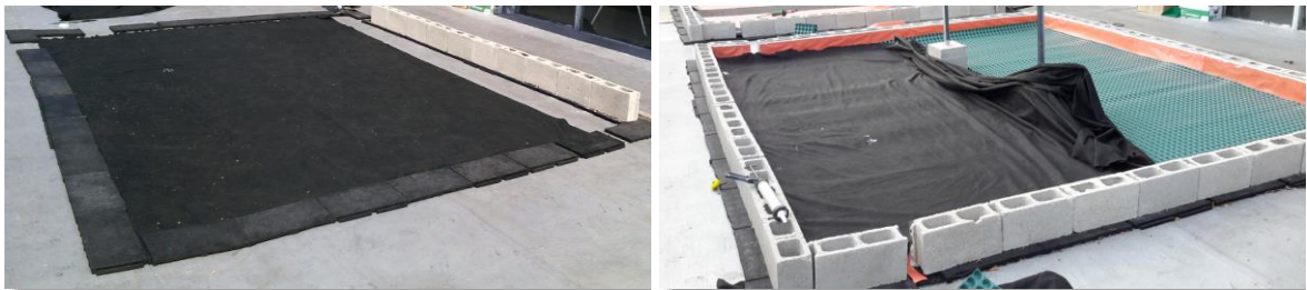
a. Ubicación y construcción perimetral.
