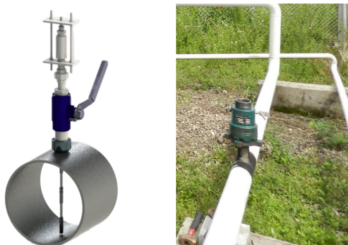
Figura 6: Instalación de Cupón
