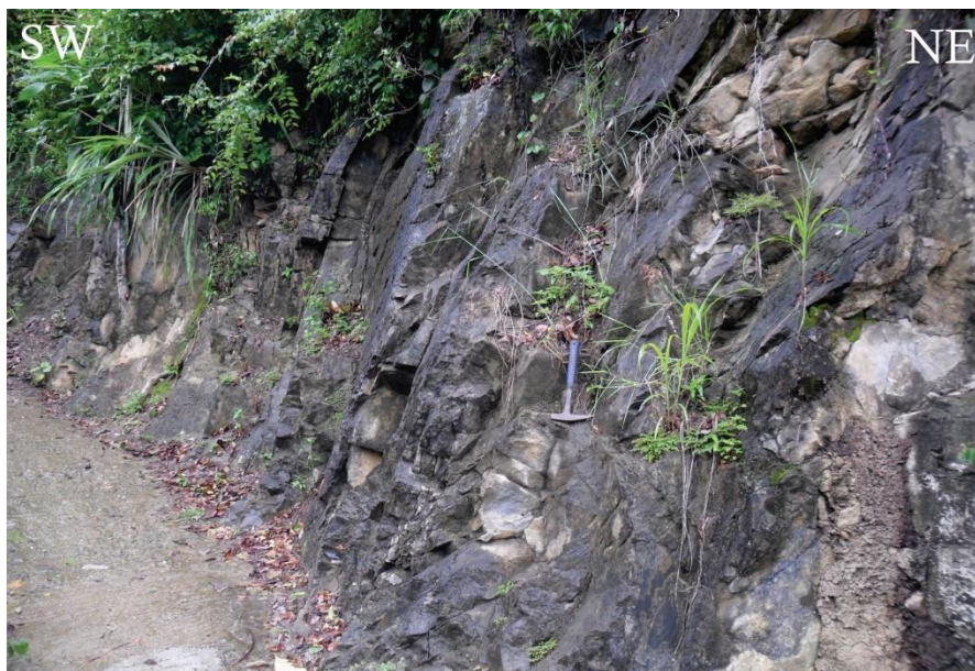
Figura 67. Parte superior de la Formación Bocas, Vía Bucaramanga-Rionegro
