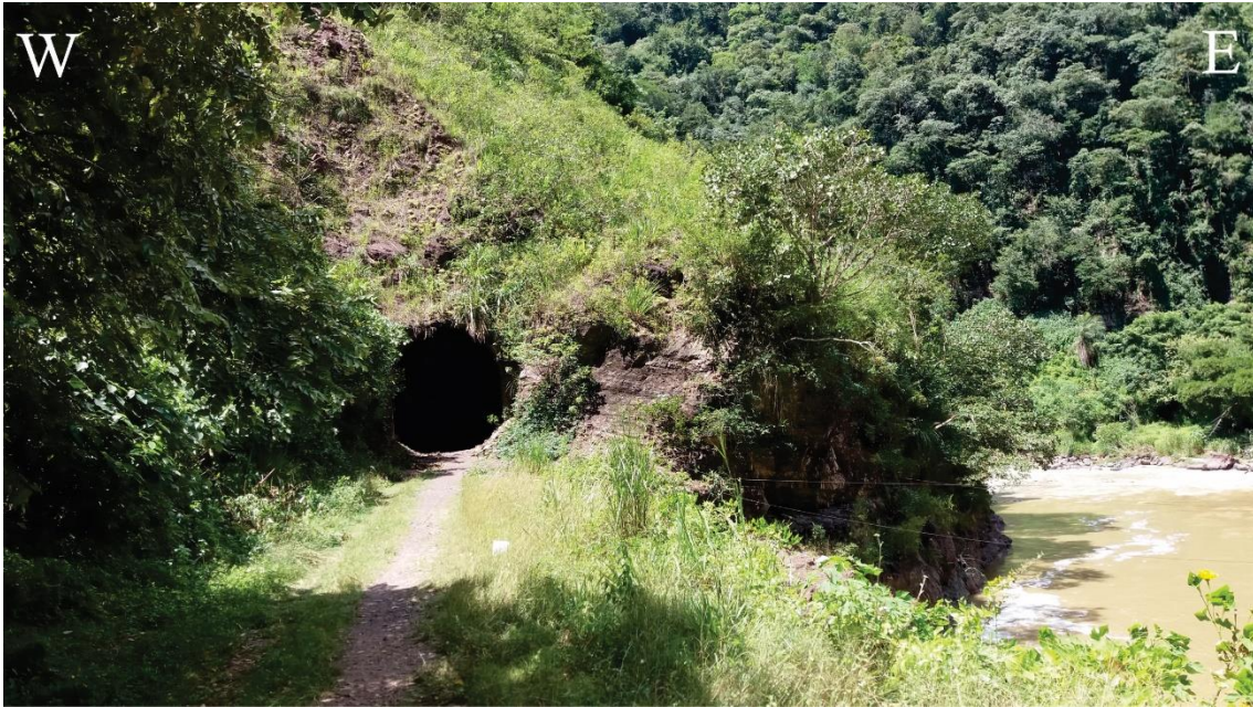
Figura 8. Afloramiento del Segmento G sobre salida del túnel perteneciente a la antigua Vía férrea.
