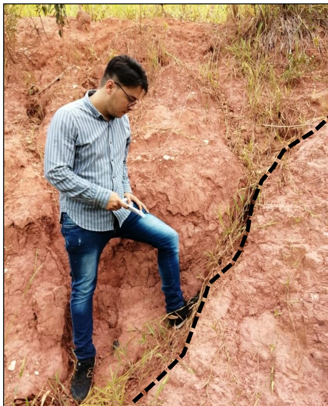
Figura 41. Roca vs Suelo, se observa el tope de la berma 1 y un contacto fallado entre la unidad cartografiada como Deposito de Talud (Qdt) y Formación Jordán (Jj). Imagen de 7 de abril de 2019.
