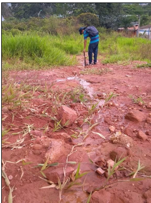
Figura 88. Surcos en el extremo norte, con flujo libre de aguas drenadas sobre el talud terraceado. Foto tomada en 25/Mayo/2019.
