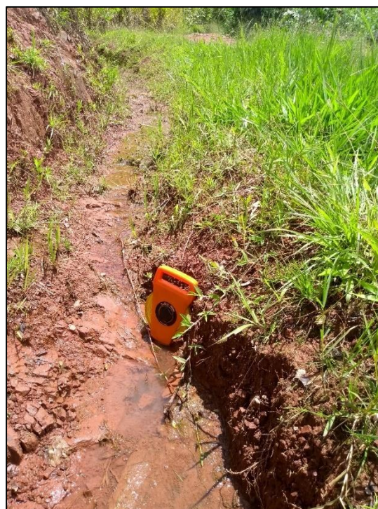
Figura 83 y Figura 84. Cuneta derruída (sin bordillos), con flujo hacia la persona, al sur (imagen izquierda) y detalle de la misma cuneta, en su inicio canalizado, vista hacia el NW (imagen derecha). Foto tomada en 01/Junio/2019.
