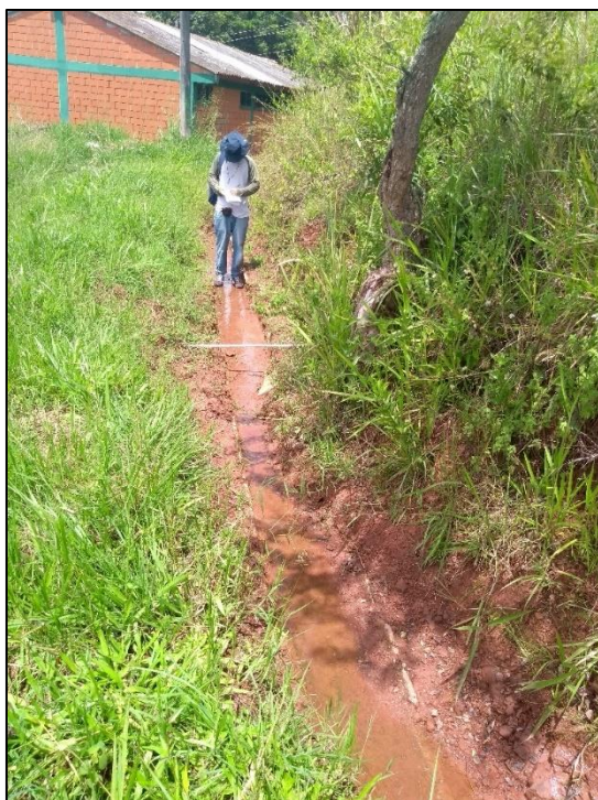
Figura 83 y Figura 84. Cuneta derruída (sin bordillos), con flujo hacia la persona, al sur (imagen izquierda) y detalle de la misma cuneta, en su inicio canalizado, vista hacia el NW (imagen derecha). Foto tomada en 01/Junio/2019.
