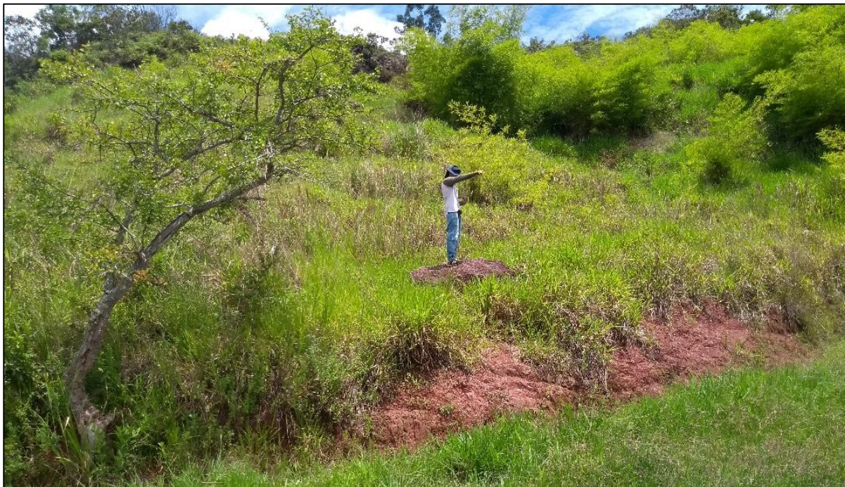
Figura 35. Depósito Coluvial Reciente (Qcr): vista a la zona desestabilizada en el año 2013, con un gran bloque rocoso (persona para sobre el), ubicada al sur sobre la berma 1.
