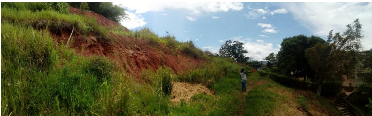
Figura 67. Vista al norte desde la berma de la terraza inferior, frente al costado occidental de las manzanas, y de los taludes de las terrazas 2 y 3.
