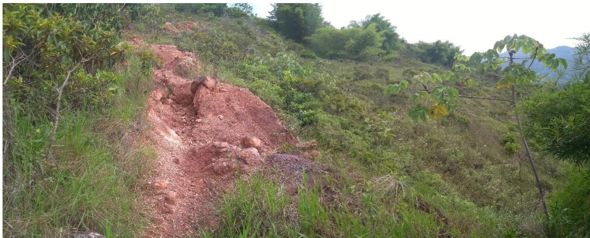
Figura 76. Vista al noroccidente del elemento morfológico laderas cóncavas (Dlc).
