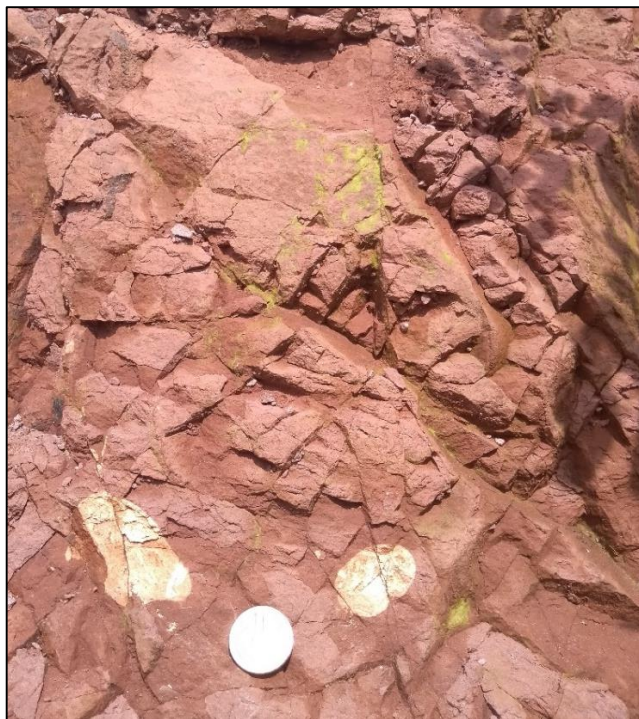
Figura 47. Formación Jordán (Jj) afectada por sistemas de fracturación dominantes (más largos) y subordinados (irregulares y poco extensos). Se observaron hasta tres familias de diaclasas ortogonales a romboédricas. Abajo se notan unos nódulos caolinífticos, cuyo diámetro centimétrico se compara con una moneda de 200 COP.
