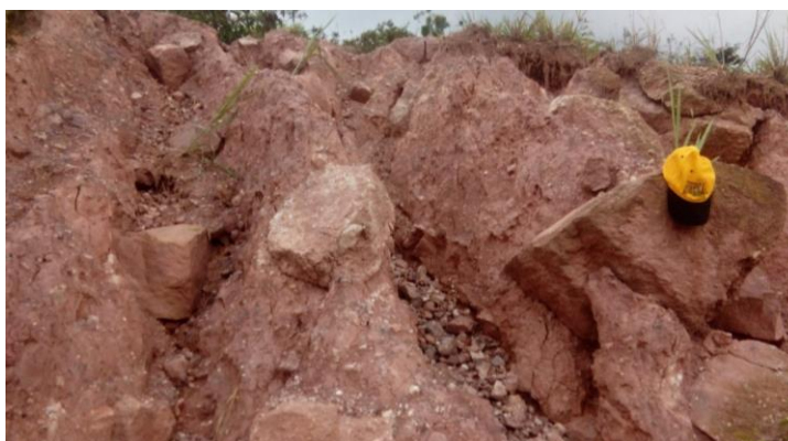
Figura 53. Depósito coluvial reciente (Qcr) observado en la vía norte hacia el Cerro la Cantera, antes de los tanques de agua. Foto tomada en 20/Abril/2019 y suelos traslocados denudados en la parte alta, foto tomada el 13/Junio/2019.
