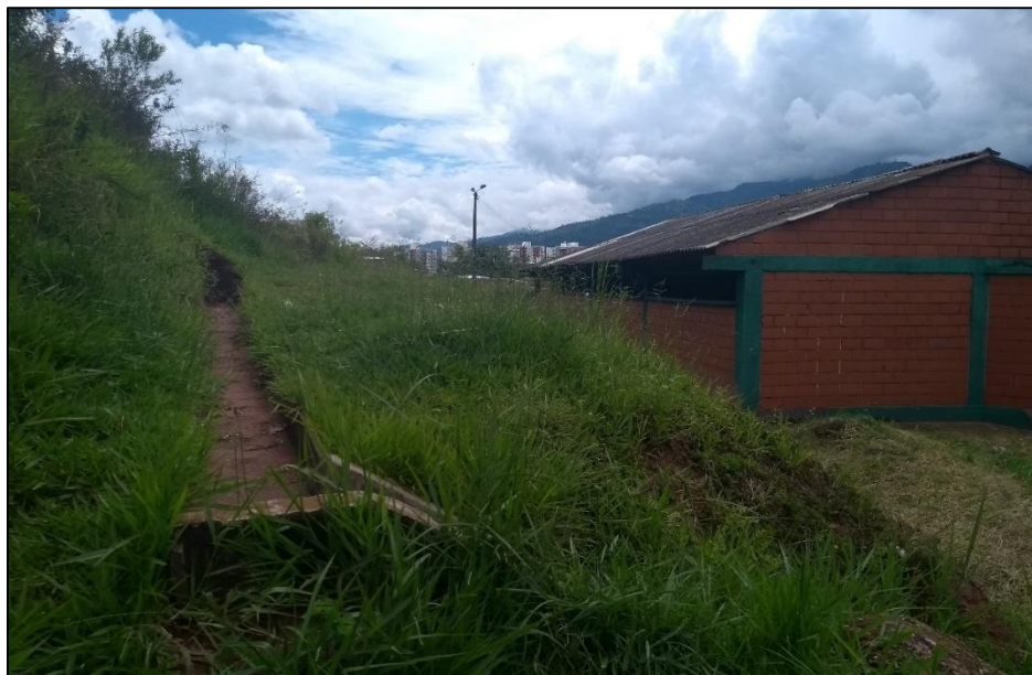
Figura 82. Arriba cuneta y dissipador al frente. Costado sur, detrás de la caseta comunal. Foto tomada el 1/Junio/2019.
