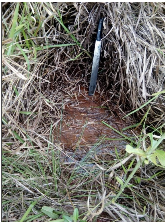
Figura 86. Empozamiento de aguas (o zona húmeda) en la cuneta de la berma, cerca al sitio de foto anterior. Foto tomada en 25/Mayo/2019.
