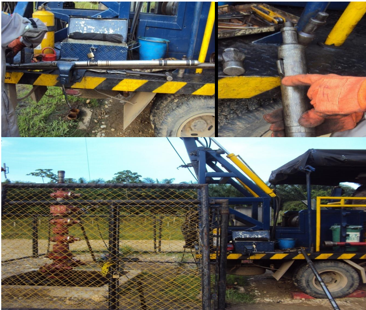
Figura 28. Pruebas de injectividad pozo T-015 con Unidad Slick Line
