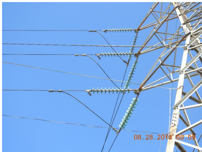
Figura 5. Estructura metálica de retención
