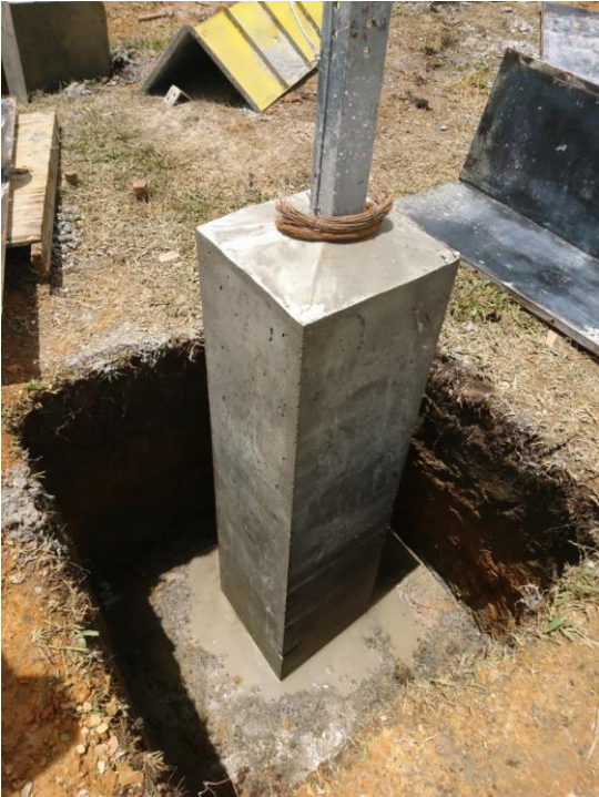
Figura 8. Proceso de curado de cimentación
