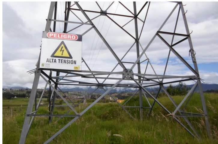
Figura 16. Señalización de seguridad.
