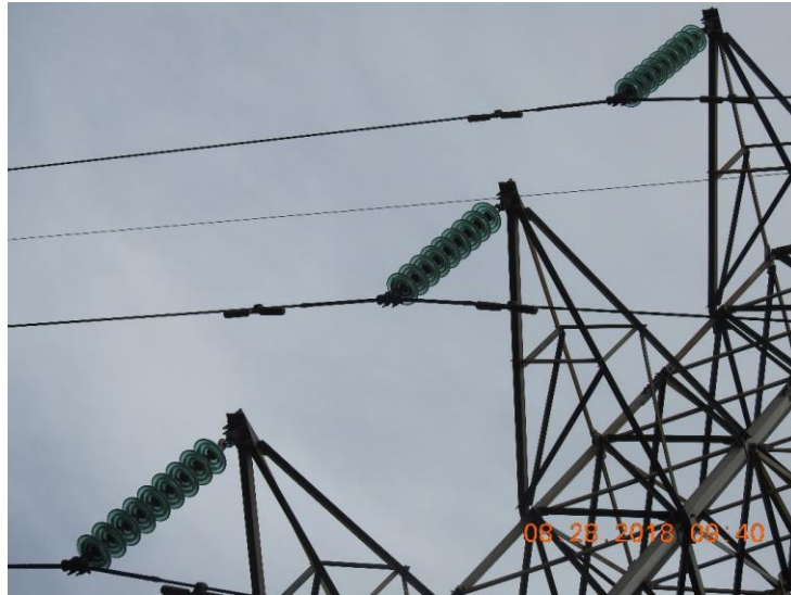
Figura 6. Estructura metálica de suspensión
