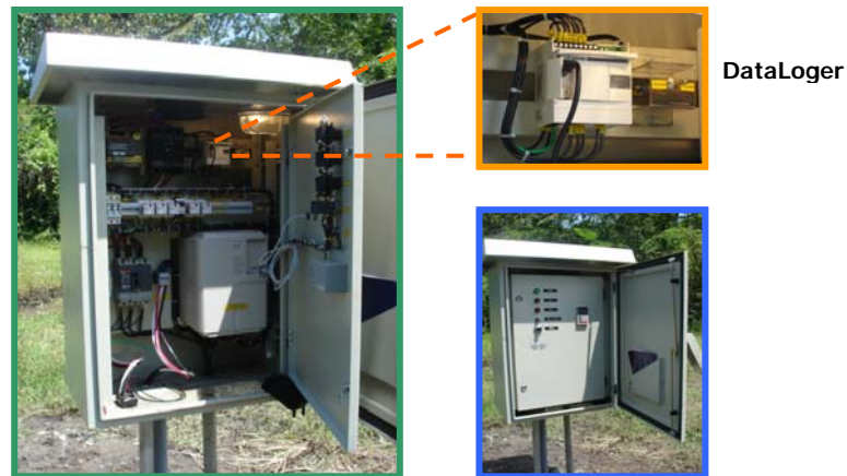
Figura 19. Variador de Frecuencia
