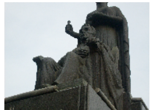
Fig.18 El parque Bolívar: Deterioro en el monumento
