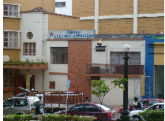
Fig. 23 Parque Bolívar: instituciones a su alrededor
