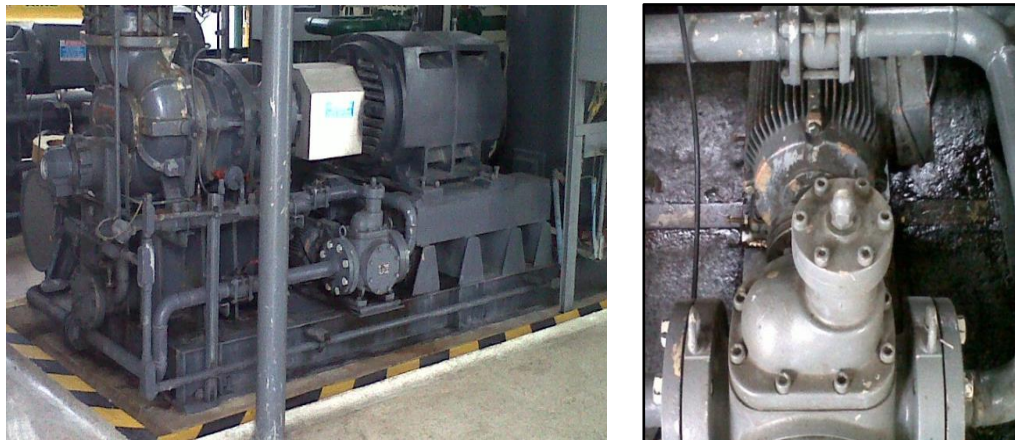
Figura 40. Contaminación por aceite en el compresor.
