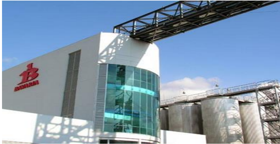
Figura 6. Edificio cocinas cervecería Bavaria planta Bucaramanga.
