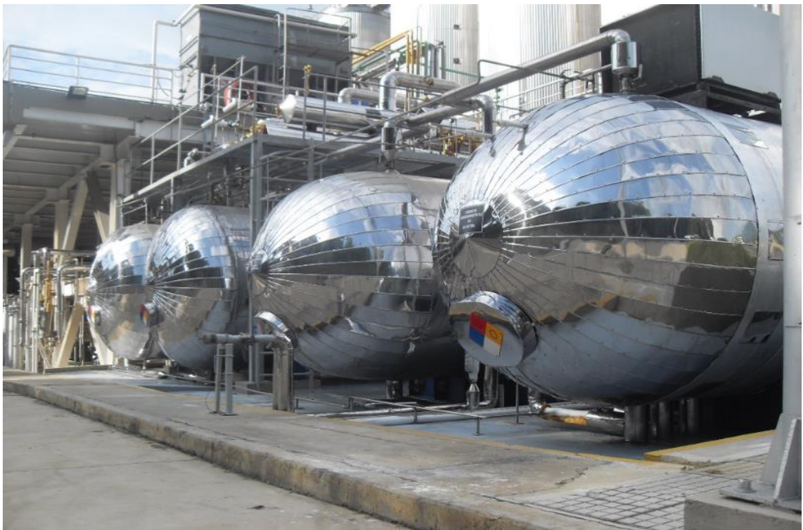
Figura 1. Área de servicios industriales.
