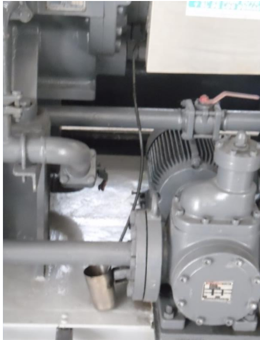
Figura 44. Corrección al goteo de aceite.
