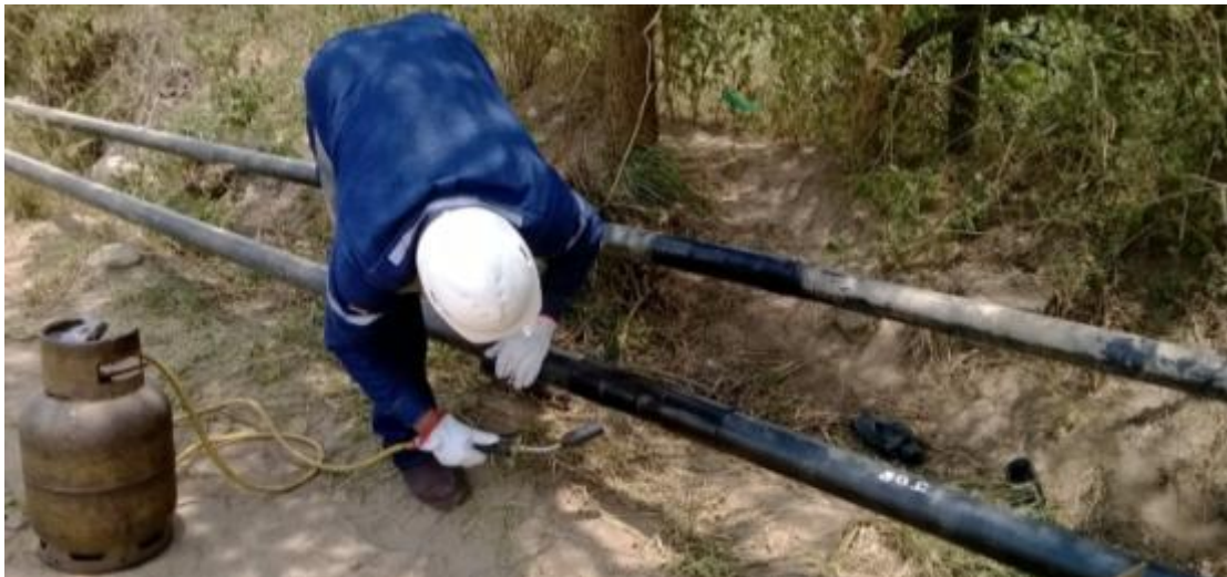
Figura 28. Calentamiento de la manta termocontraíble.
