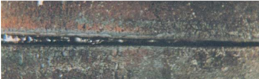
Figura 40. Penetración de junta incompleta.
