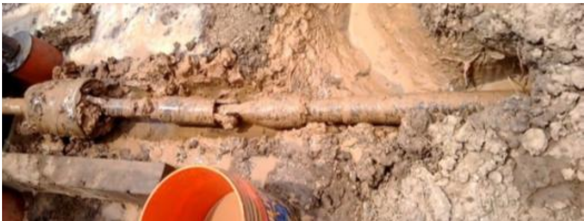
Figura 17. Halado de la sarta de perforación.
