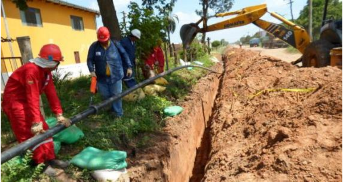
Figura 30. Bajado de tubería con ayuda de retroexcavadora.
