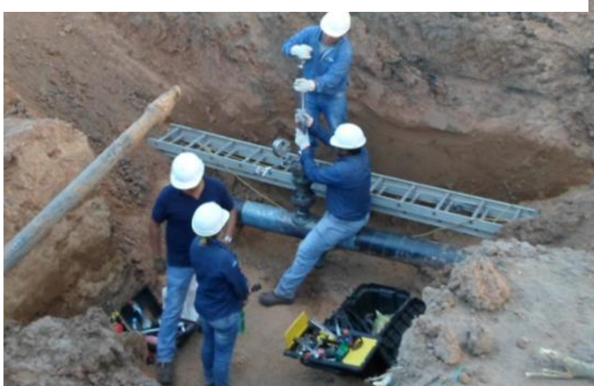
Figura 9. Uso de máquina para perforar una sección del gasoducto de 10”.
