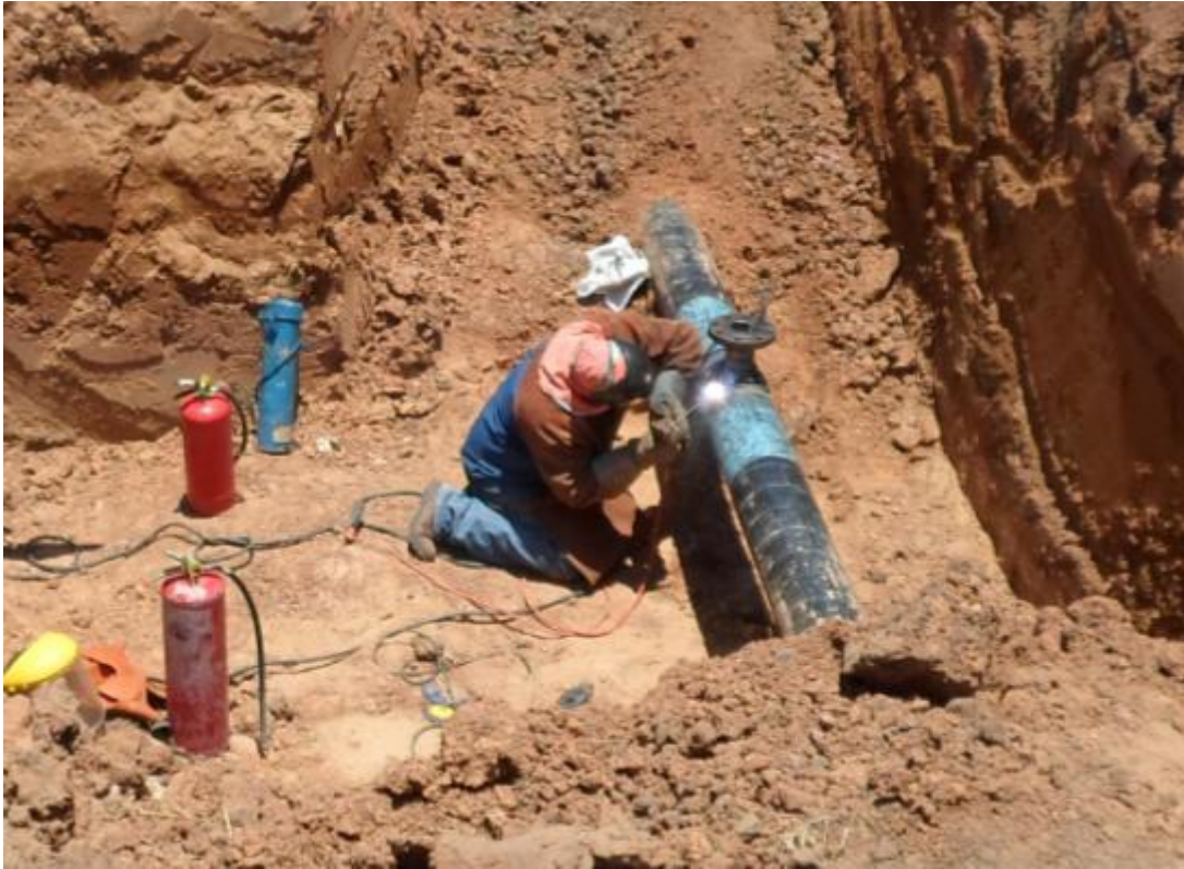
Figura 6. Soldadura del accesorio a la tubería de 10”.
