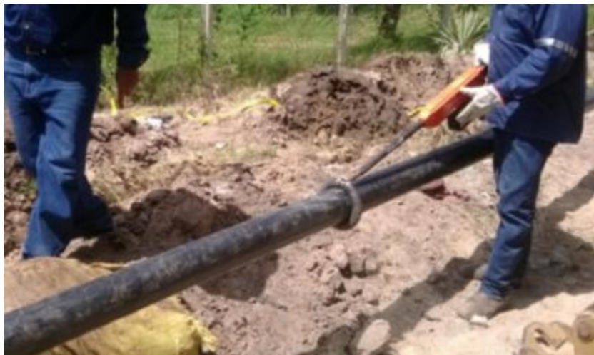
Figura 29. Inspección de la tubería con el Holiday Detector.
