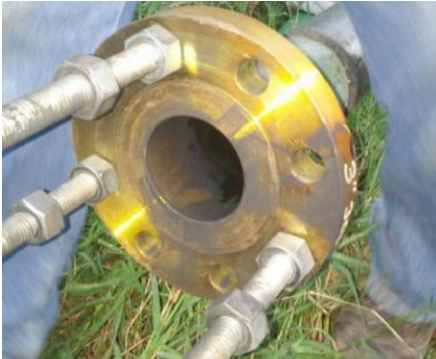
Figura 34. Ajuste de bridas y espárragos.
