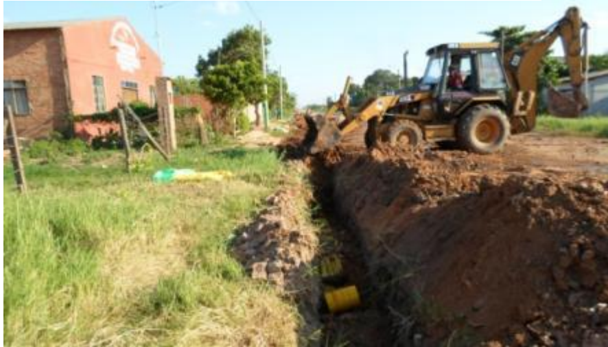
Figura 12. Retroexcavadora haciendo trabajo de relleno de zanja.
