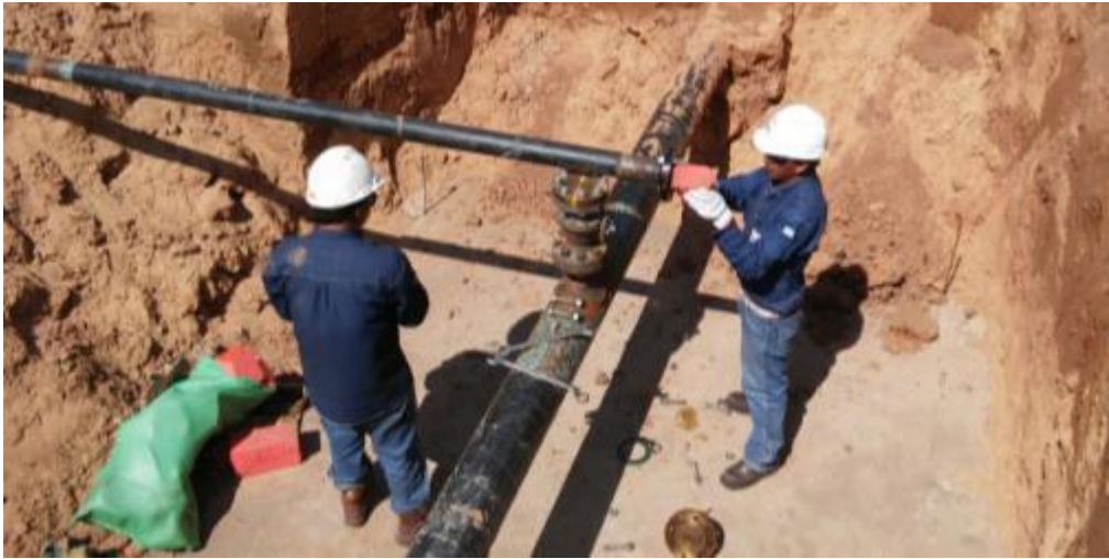
Figura 54. Introducción de limpiadores de espuma al inicio de la línea.
