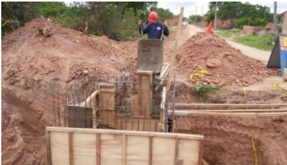
Figura 20. Construcción de la cámara de hormigón armado.
