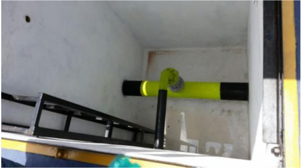
Figura 21. Interconexión al interior de la cámara finalizada.
