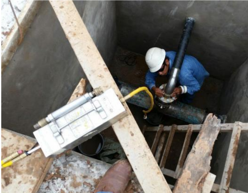
Figura 7. Inspección radiográfica a la interconexión.
