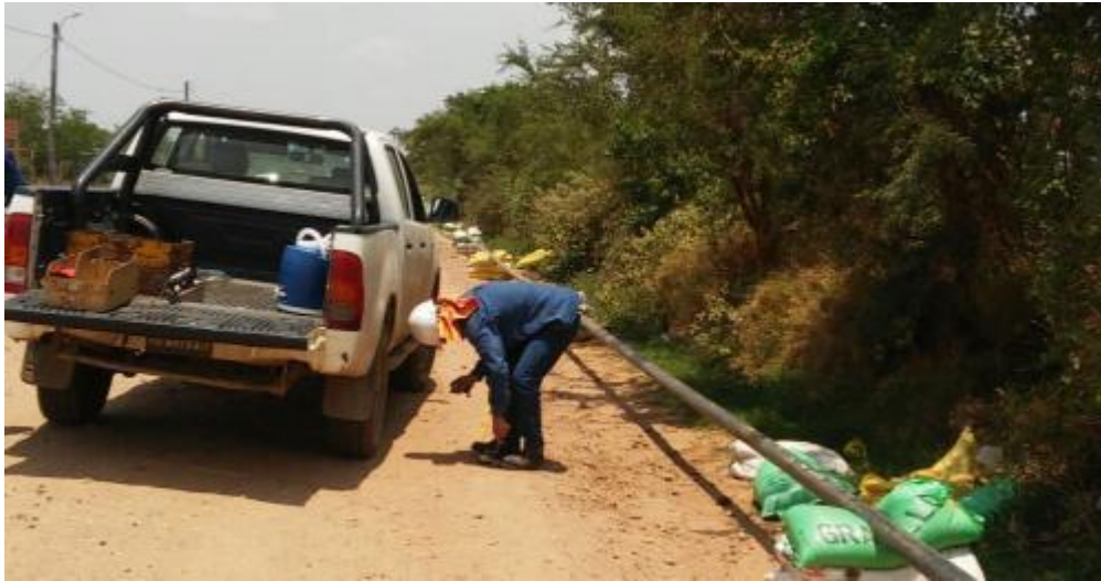
Figura 46. Inspección radiográfica a lo largo de la lingada.
