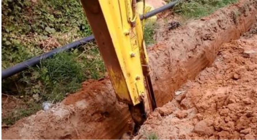
Figura 10. Excavación de zanja.
