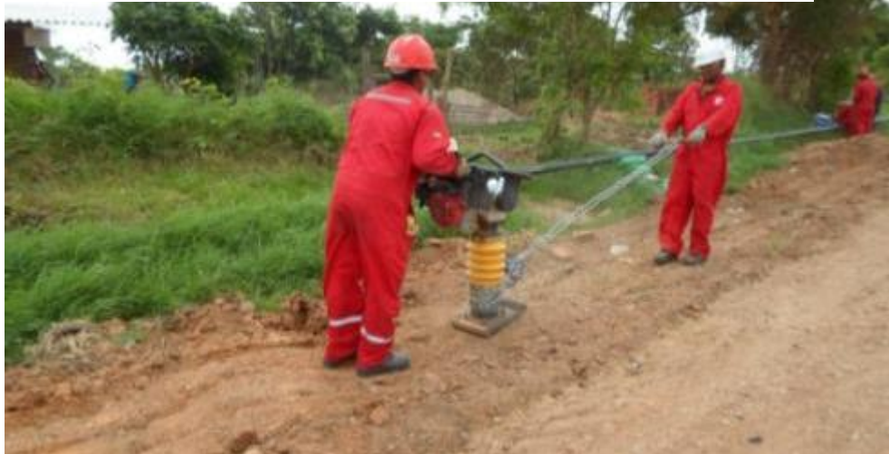
Figura 13. Uso de máquina compactadora tipo “saltarín”.
