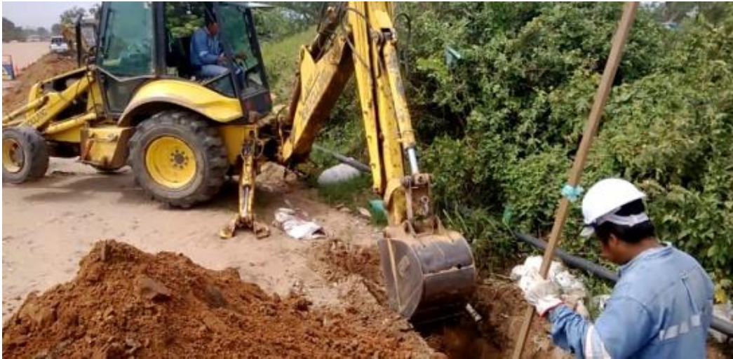
Figura 11. Retroexcavadora y su respectivo ayudante con indicador de profundidad.
