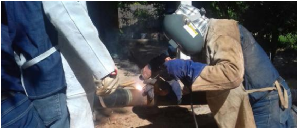
Figura 27. Soldadura de tubos de 3”.
