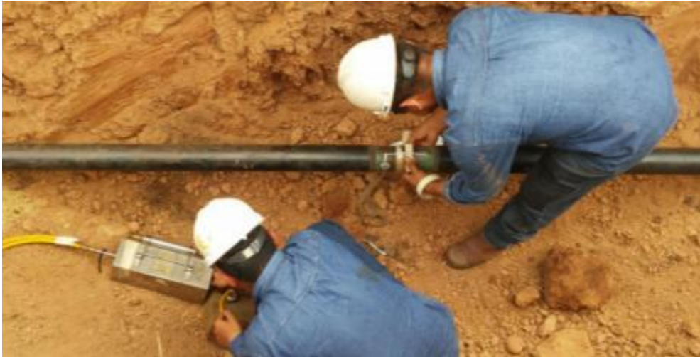
Figura 45. Inspección radiográfica al interior de la zanja.
