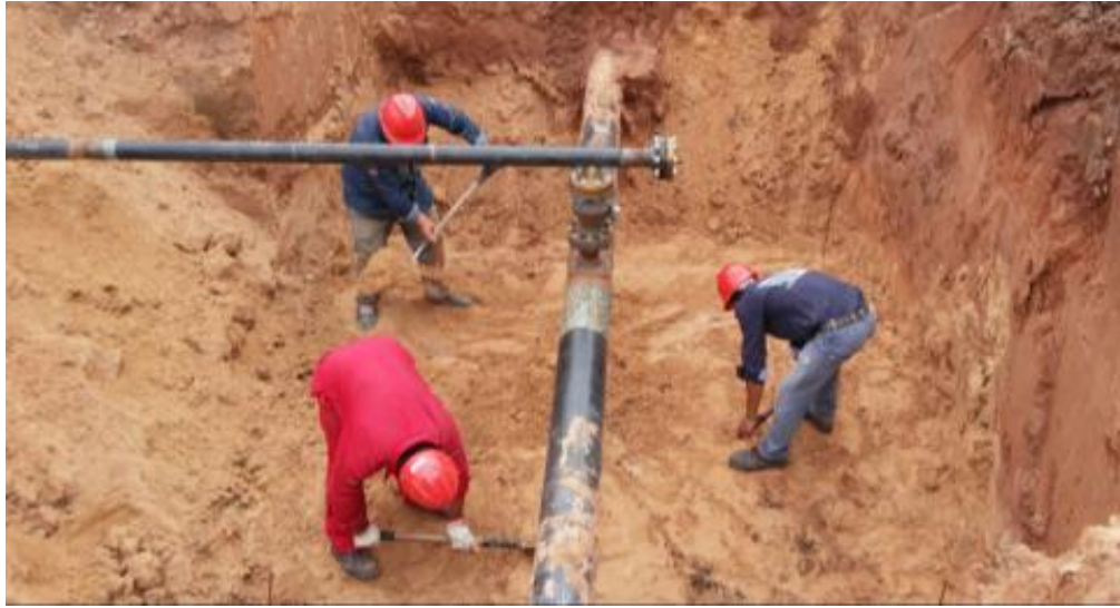
Figura 5. Procedimiento hot tap finalizado.
