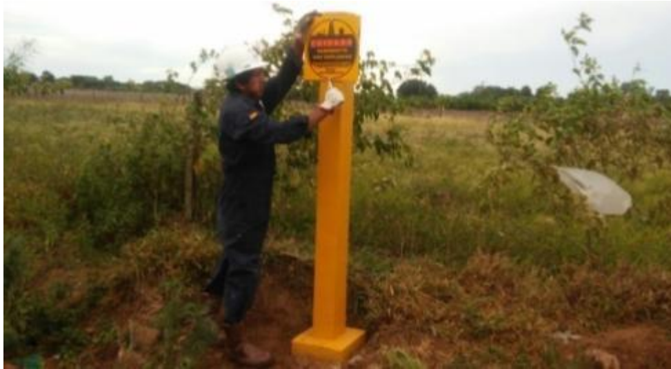
Figura 19. Instalación del letrero en el poste de señalización vertical.
