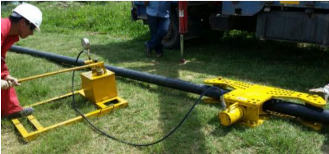
Figura 25. Curvado de tubería.
