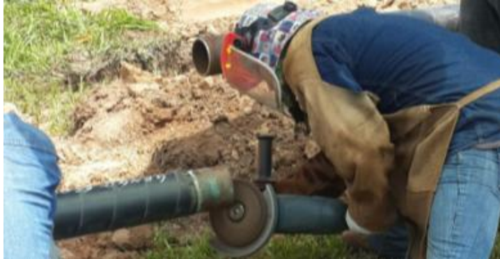
Figura 26. Biselado de las extremidades del tubo por un técnico amolador.
