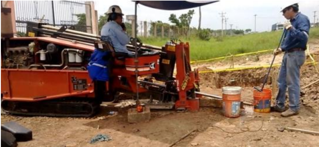
Figura 14. Equipo de perforación dirigida, operador y ayudante.
