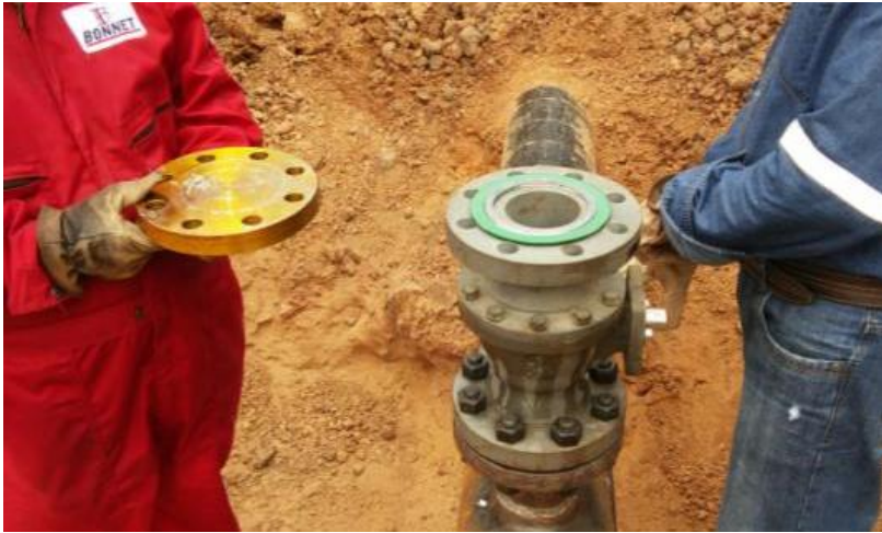
Figura 8. Postura de brida con su respectivo sello hermético.
