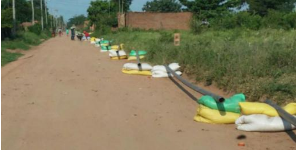
Figura 24. Desfile de tubería sobre sacos con relleno suave.
