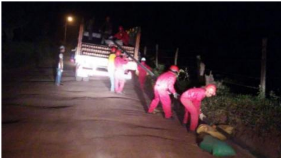
Figura 23. Descargue de la tubería en el derecho de vía.
