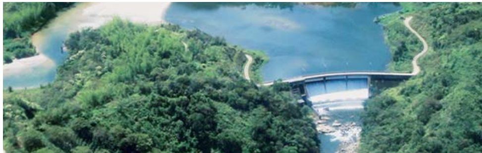
Figura 4. Central Hidroeléctrica Calderas
