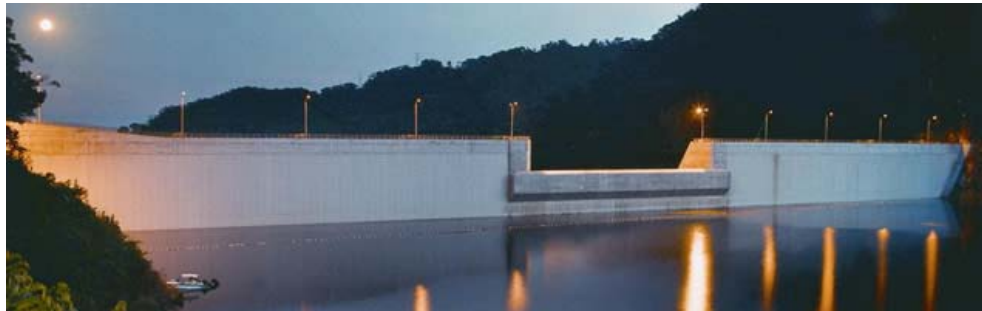
Figura 2. Central Hidroeléctrica Miel I
