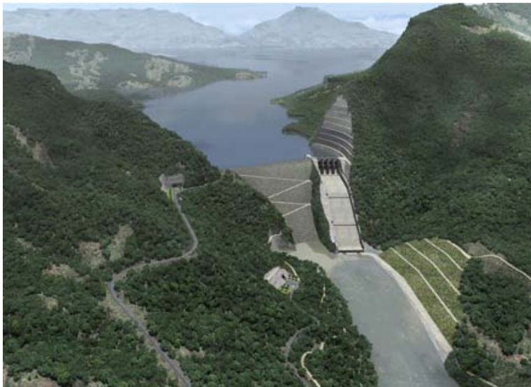
Figura 9. Imagen virtual de la presa, el vertedero y el embalse del Proyecto Hidroeléctrico Sogamoso.
