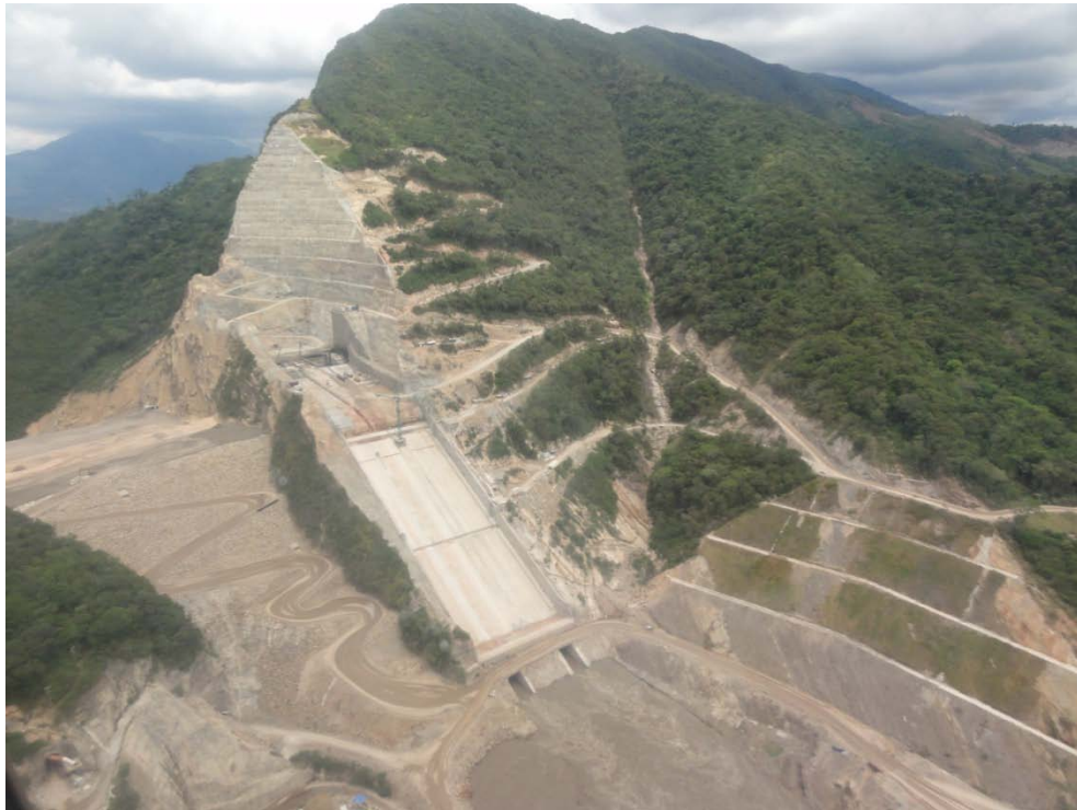
Figura 7. Proyecto Hidroeléctrico Sogamoso
