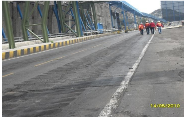
Figura 33. Grietas transversales
