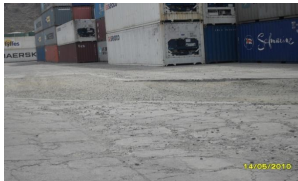
Figura 31. Losas destrozadas
