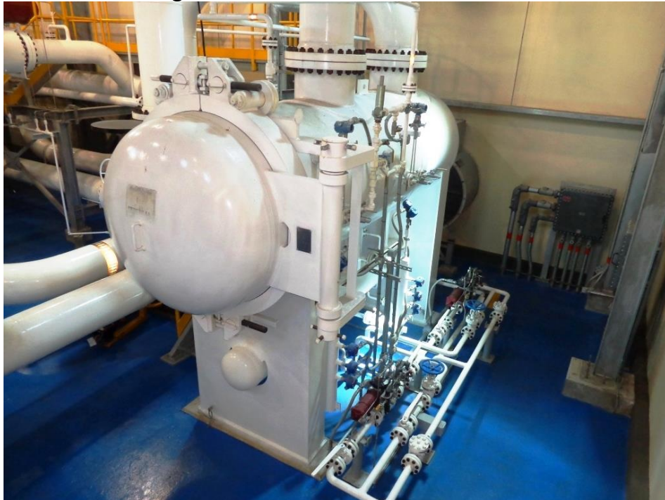
Figura 5. Filtro de succión ECGSB.
