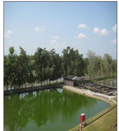
Piscina del Sistema contraincendios
