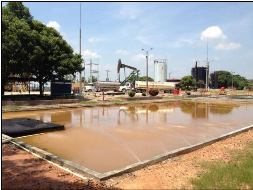
Imagen10. Piscina de oxidación
