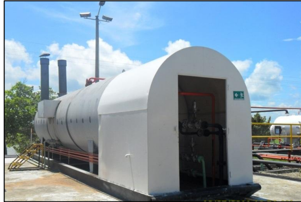
Imagen 5. Estructura del Tratador térmico
