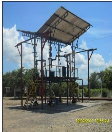
Tanques de almacenamiento
