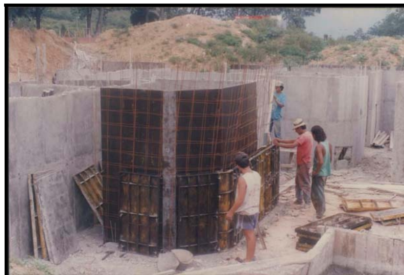
Figura 19- Ubicación de la formaleta de Edificación 6
