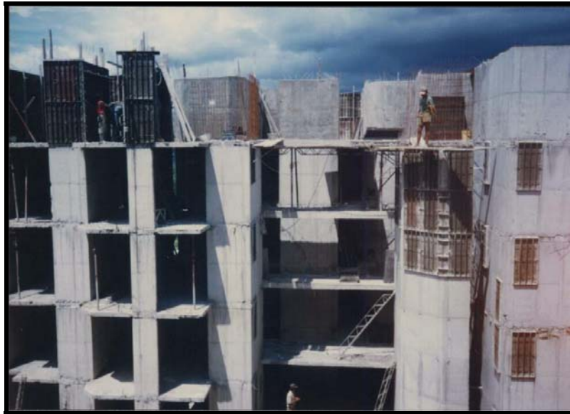
Figura 18- Proceso de desencofrado de Edificación 6
