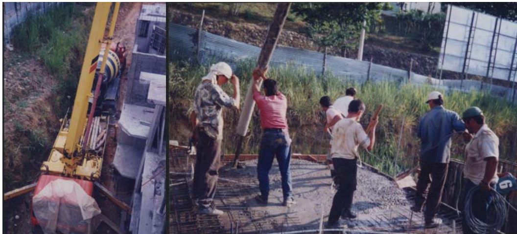
Figura 21- Fundición del Concreto de Edificación 6
