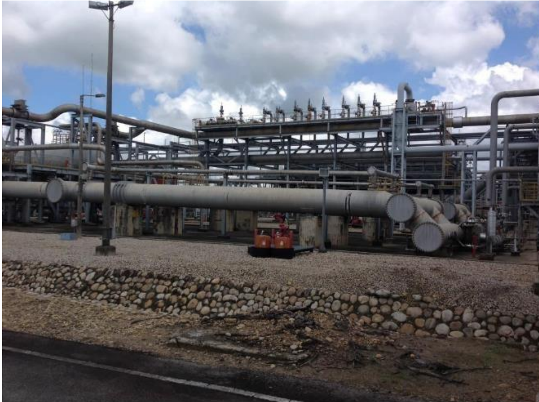
Figura 18. Slug catcher- Planta Cusiana. Fuente: Operaciones planta Cusiana Equion.
