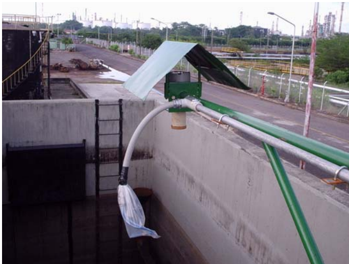
Figura 12. Medidores nuevos instalados
