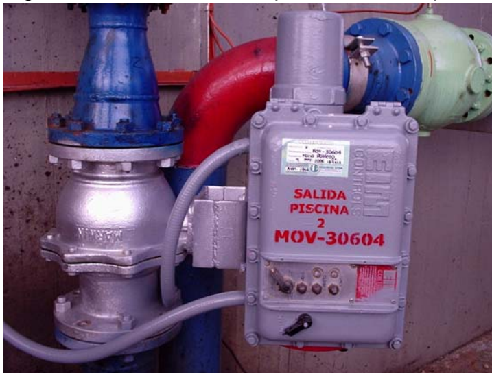
Figura 13. Válvulas MOV'S posterior a su reparación
