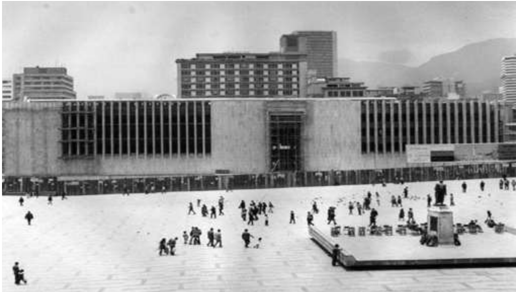
Foto No. 1 Palacio de Justicia en construcción
