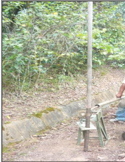
Figura 26. Sondeo 2 Fuente: Propia
