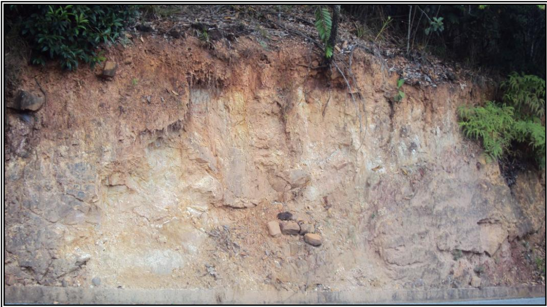
Figura 7. Desprendimientos de masas de coluvión Fuente: Propia
