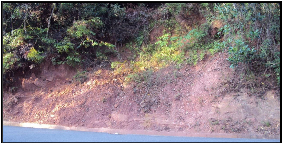
Figura 21. Presencia de suelos residuales y rocas meteorizadas Fuente: Propia
