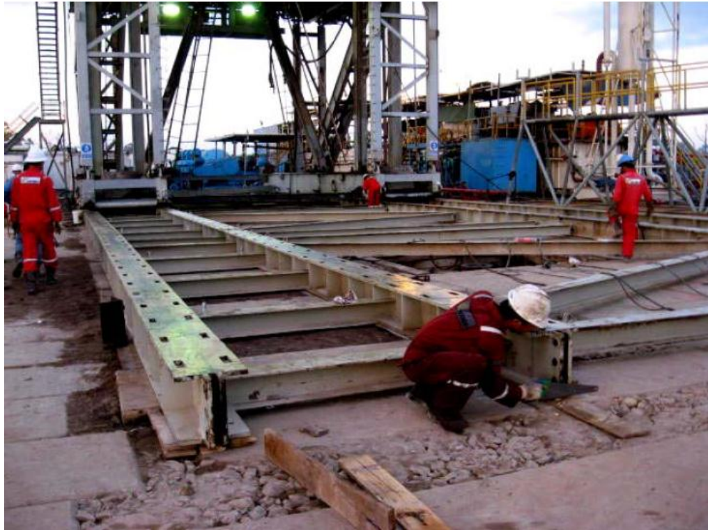
Figura 30. Sistema de deslizamiento para una torre de perforación.
