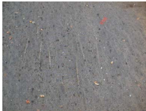
figura 2.4 Asentamiento Longitudinal
