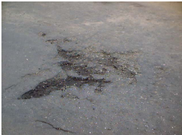
Figura 2.6 Peladura
