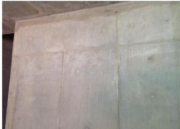
Figura 14. Resane técnico del hormiguo
