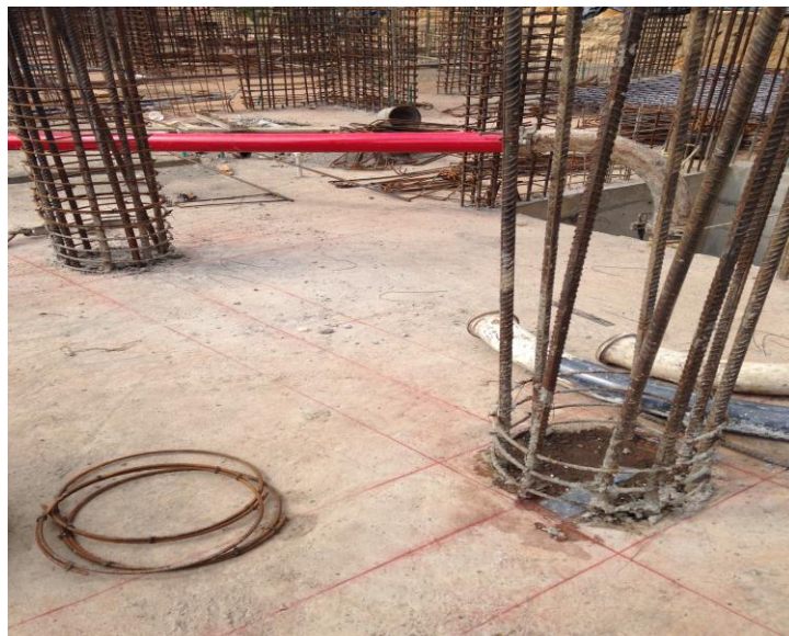
Figura 3. Cimbrado de ejes principales y auxiliares
