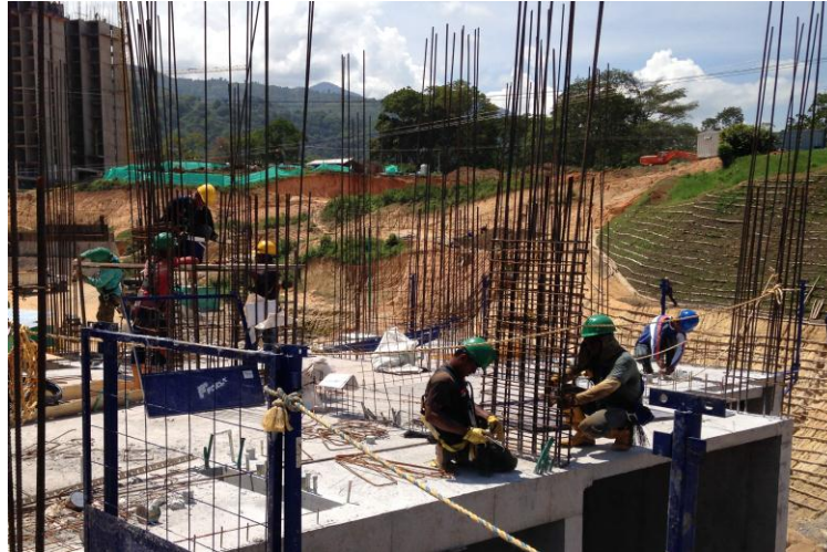
Figura 6. Verificación del acero de refuerzo
