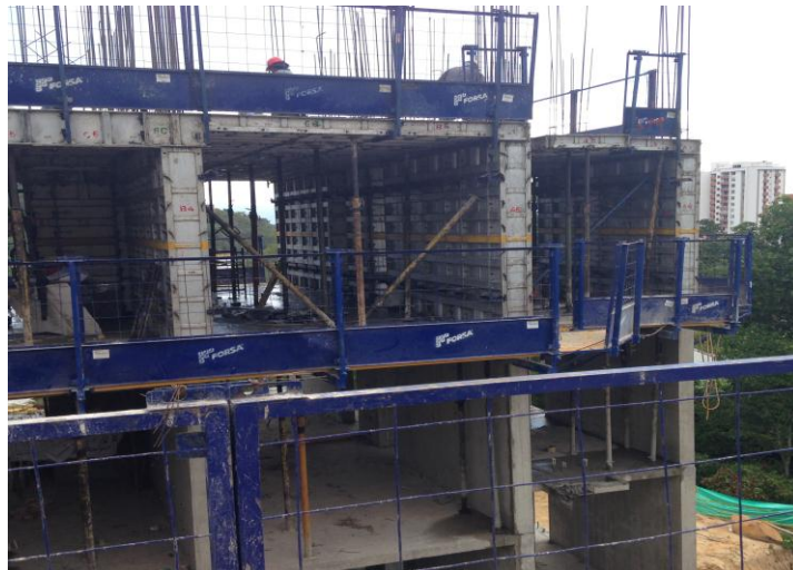
Figura 13. Instalación de pasarelas
