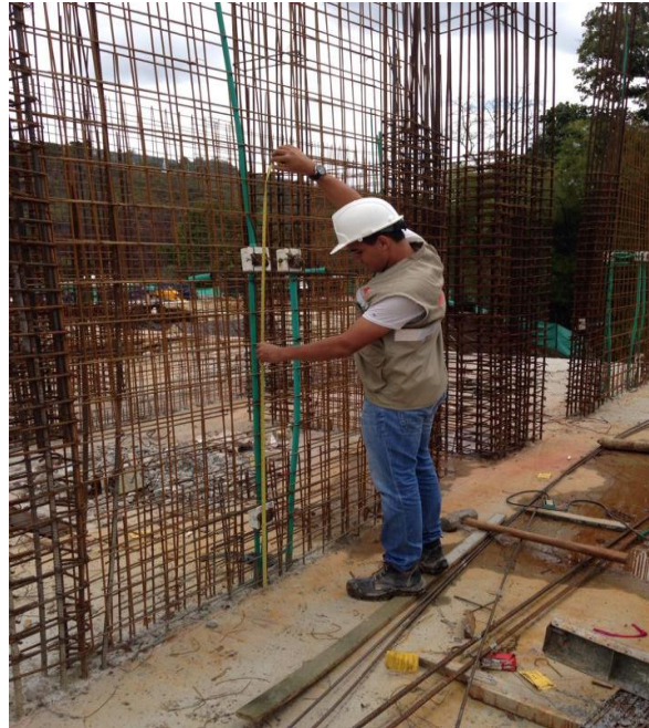
Figura 5. Instalación de mallas y redes
