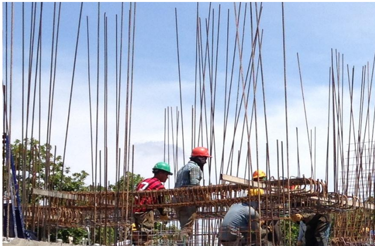
Figura 10. Armado de vigas
