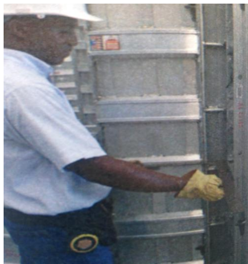
Figura 7. Verificación de escuadras
