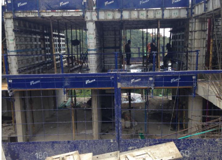
Figura 11. Armado final de Forsa
