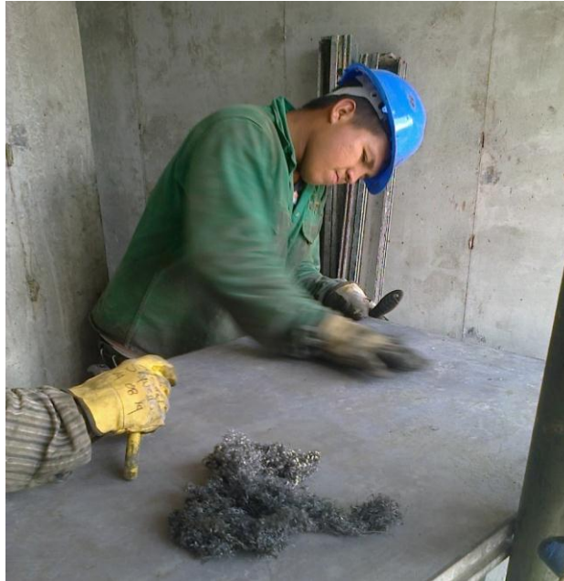
Figura 12. Limpieza posterior a la fundida
