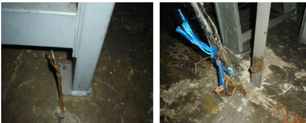
FIGURA 72. Conexión de Puesta a tierra antigua de la tarjeta de control
