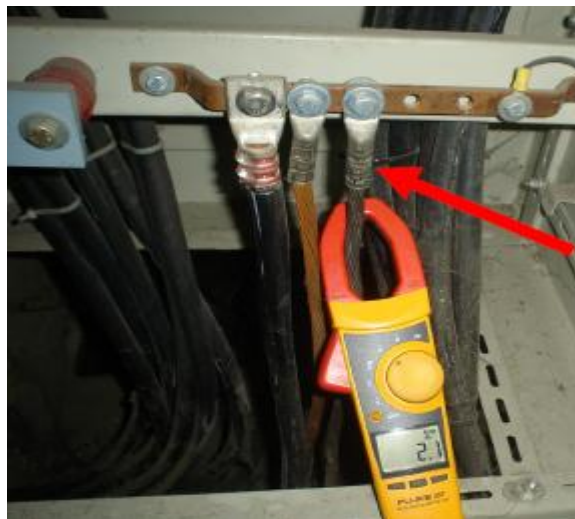
58 c. Corriente 2,1 Arms (conductor ramal 2)
