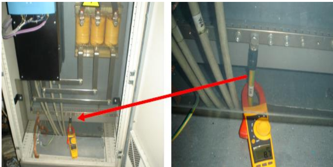
FIGURA 67. Flujo de corriente no deseado por el conductor de puesta a tierra
