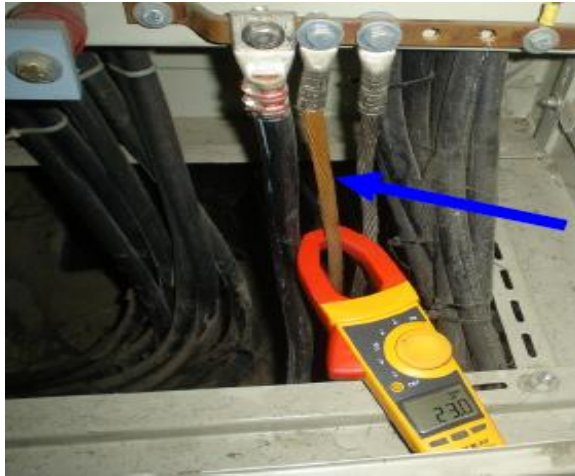
58 b. Corriente 23 Arms (conductor ramal 1)
