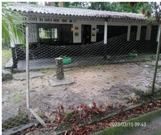
Figura11. Visita realizada a la escuela cruce de Santa Rosa sede km17.
