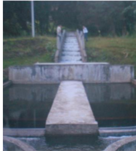
Figura 4. Estructura de aireación y desarenador Adaptado de ECOCIALT S.A.S. (2014). PAYUEDA Programa de ahorro y uso eficiente del agua. Retrieved from http://proactivasai.com/areasocial/descargas/Programa de Ahorro y Uso Eficiente del Agua.pdf
