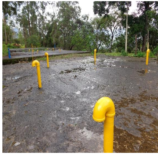
Figura 8. Tanques de almacenamiento
