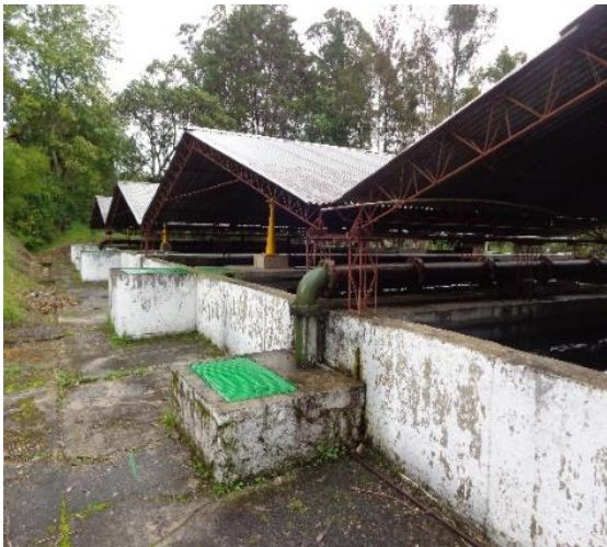
Figura 9. Tanques de almacenamiento adicionales
