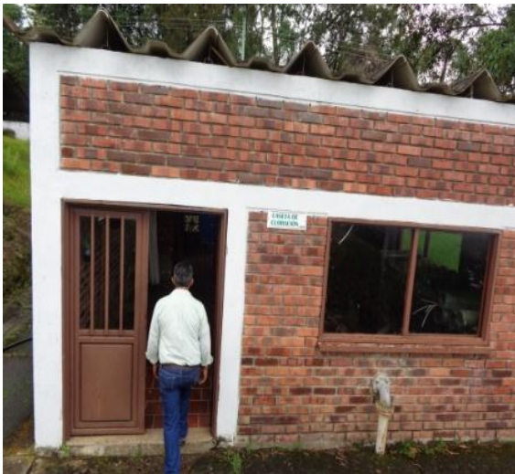
Figura 7. Caseta de cloración
