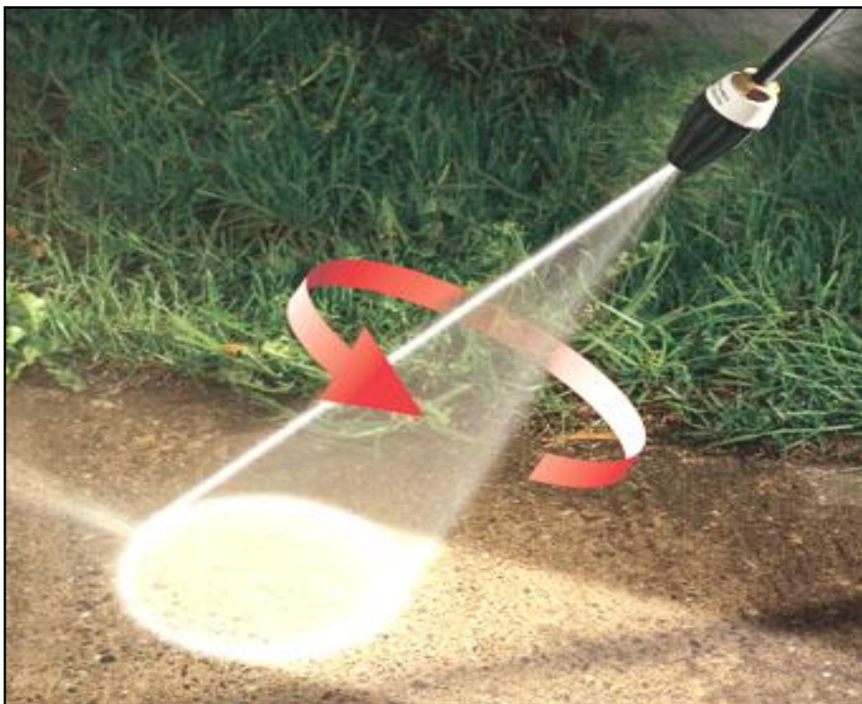
FIGURA 2: Aplicación de Hidrolavado
