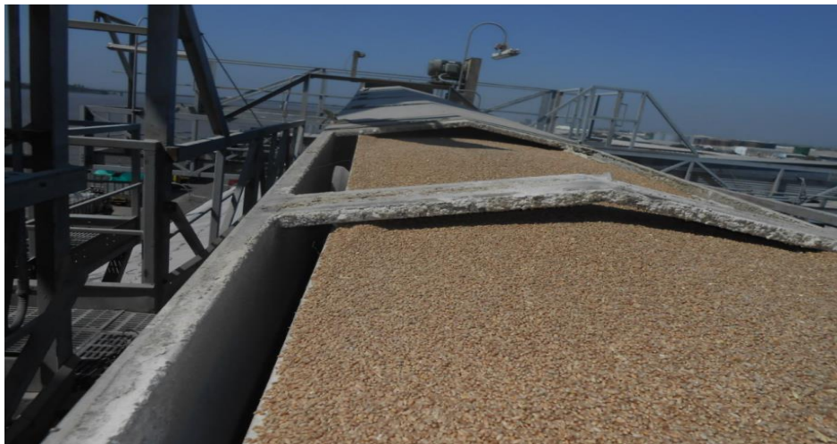
Ilustración 29. Falla por sobrecarga en la banda externa de la bodega 7A.
