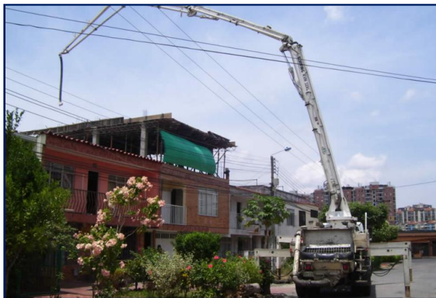
Figura 19. Bombeo de concreto
