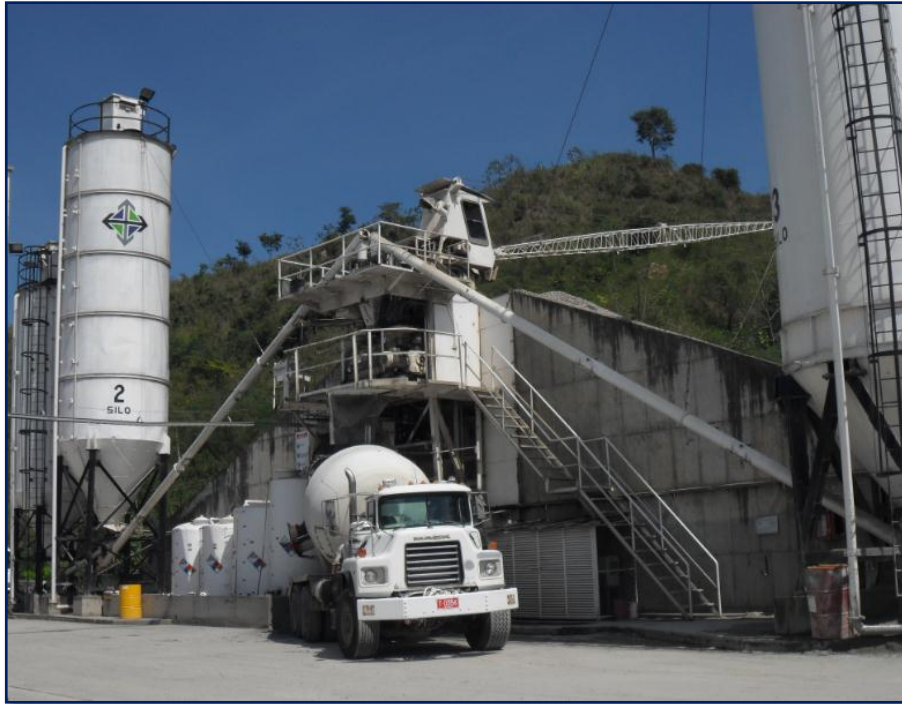
Figura 18. Cargue del concreto premezclado
