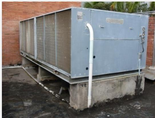
La unidad condensante consta de dos compresores semiherméticos, trifásicos, marca COPELAND.
