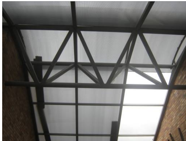
FIGURA 6: inspección cubierta; Casa Puyana
