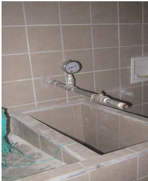
FIGURA 8: Instalación prueba Hidráulica Casa Puyana
