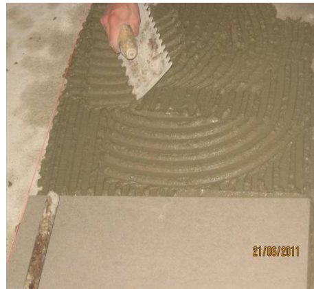
FIGURA 3: instalación mortero de pega para piso. Casa Puyana
