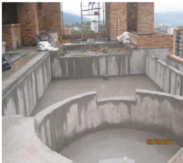
FIGURA 10: aplicación impermeabilizante piscina; Casa Puyana
