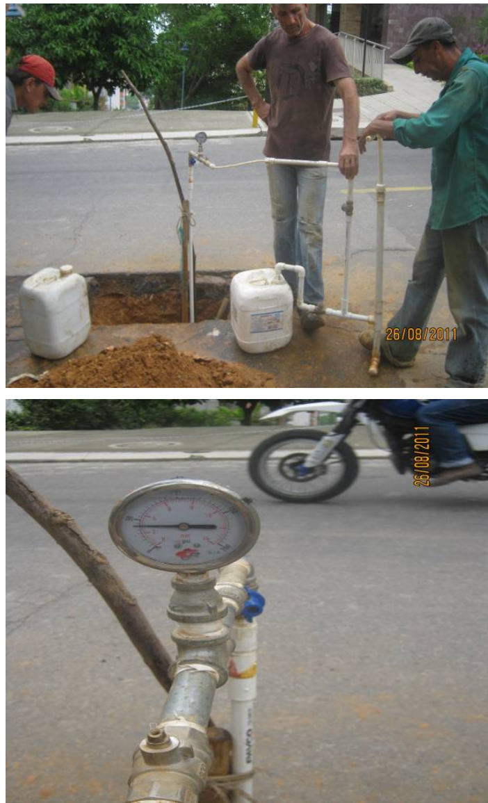
FIGURA 9. Realización prueba Hidralica red externa Casa Puayana
