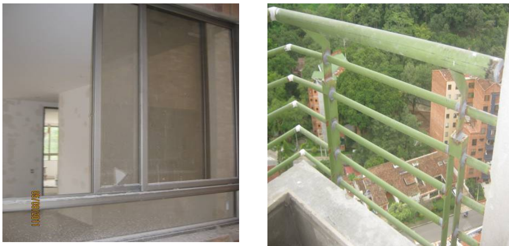
FIGURA 5: Inspección ventanas y pasamanos; Casa Puyana
