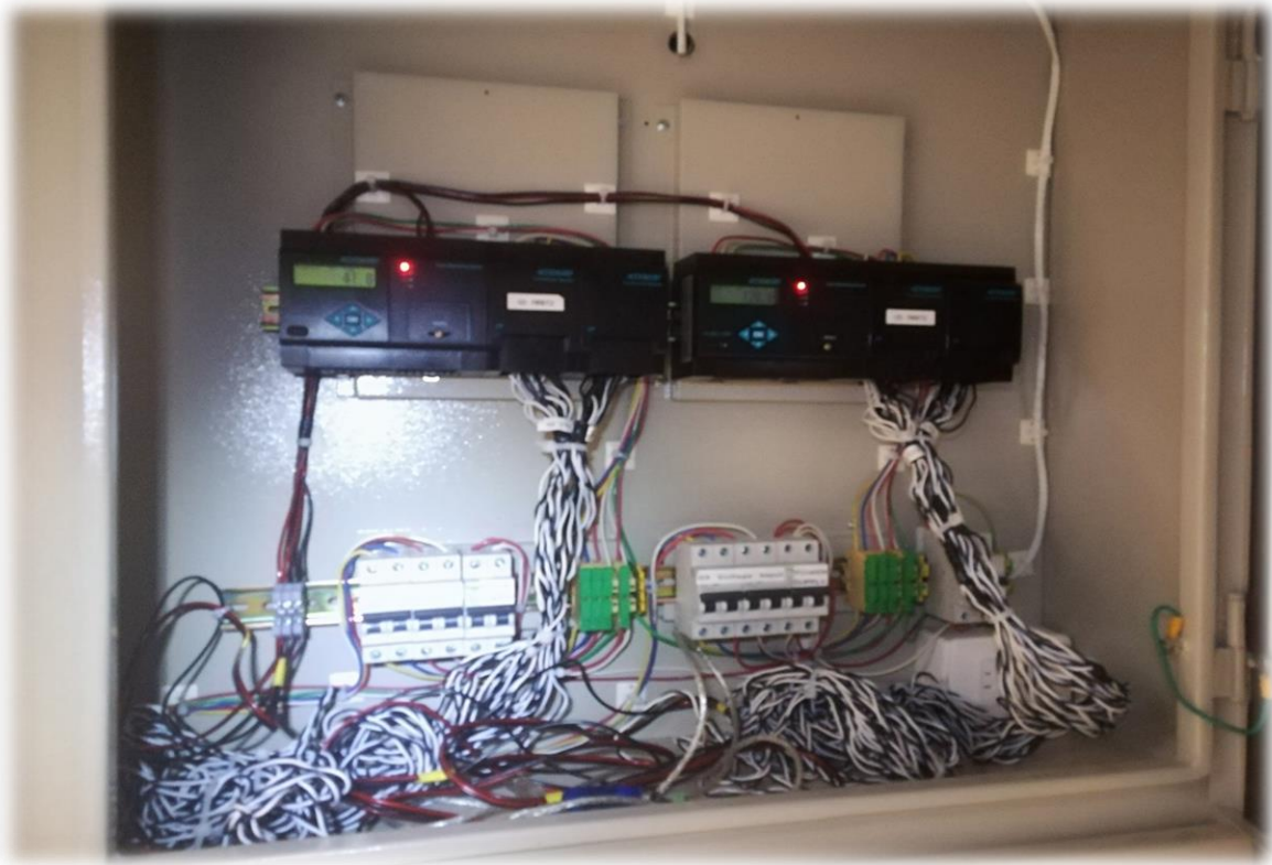
Figura 26. Medidores AcuRev2020 de los TD generales del edificio E 3 T.
