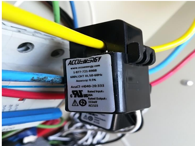
Figura 32. T.C sensando la corriente por la acometida principal de un TD de la terraza.
